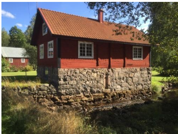
Eskils kvarn, numera ombyggd till bostad.
