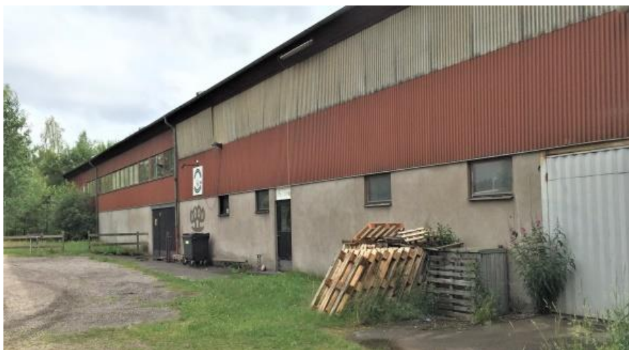
Före detta sågverksbyggnad i Väckelsång.
