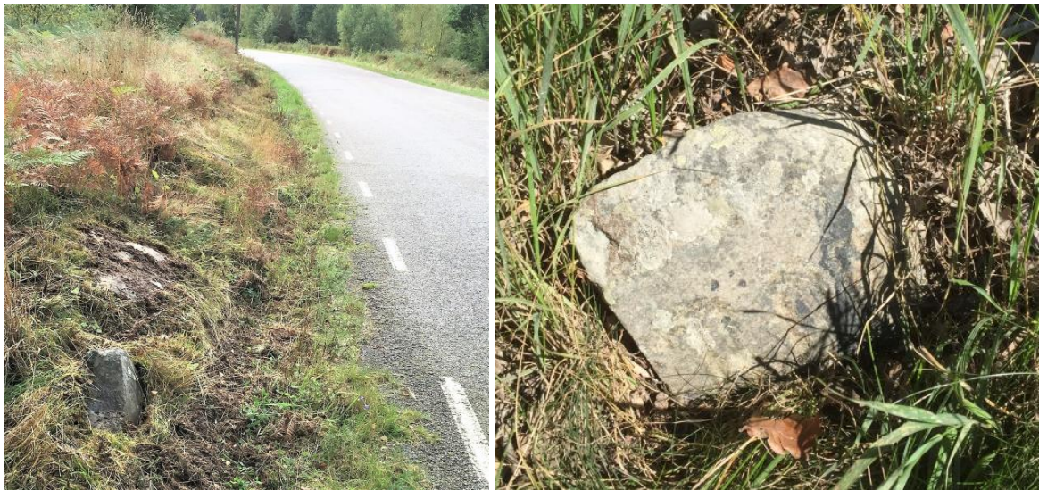
Väghållningssten (E730), skadad vid vägarbete. Enligt inventeringen 2001 avrundad upptill. Nu avslagen med kantig översida. Stenen till höger är Väckelsånga's enda väghållningssten på ursprunglig plats med inskription. Det syns inte på bilden men där står Ramö med versaler (E816). Stenen är nersjunken, alternativt har vägreken höjts. Den står i Boarydsudd längs vägen mot Drobbanäs.
