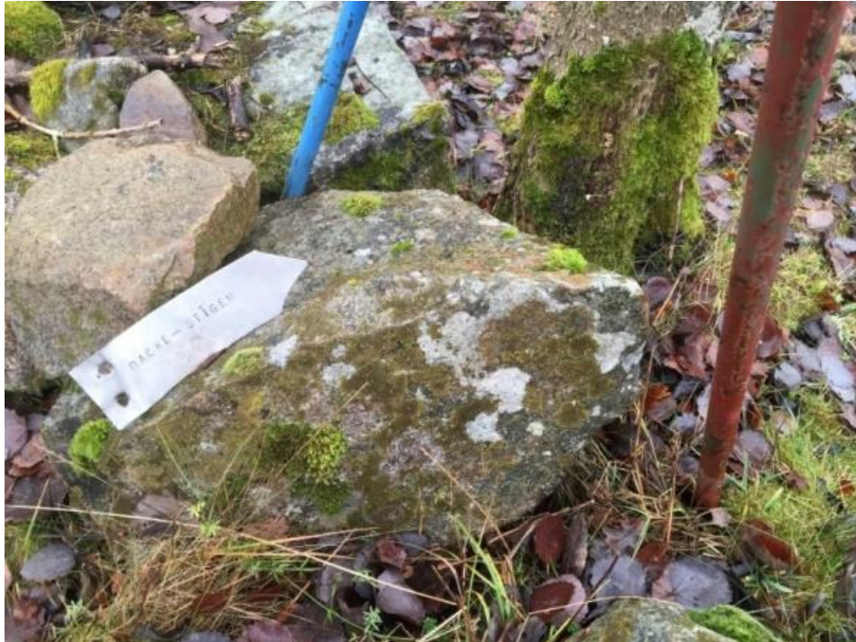
Skyltar och skyltstolpar är på en del håll i dåligt skick. Den här Dackestigsskylten finns i Boarydsudd.
