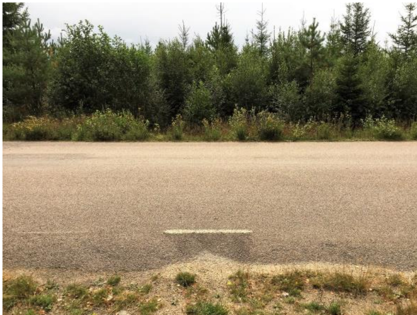
Exempel på dåliga besiktningsförhållanden. Inne i ungskogen på andra sidan vägen ligger ett röjningsröseområde som dokumenterades 2001. Gissningsvis var sikten väsentligt bättre då.
