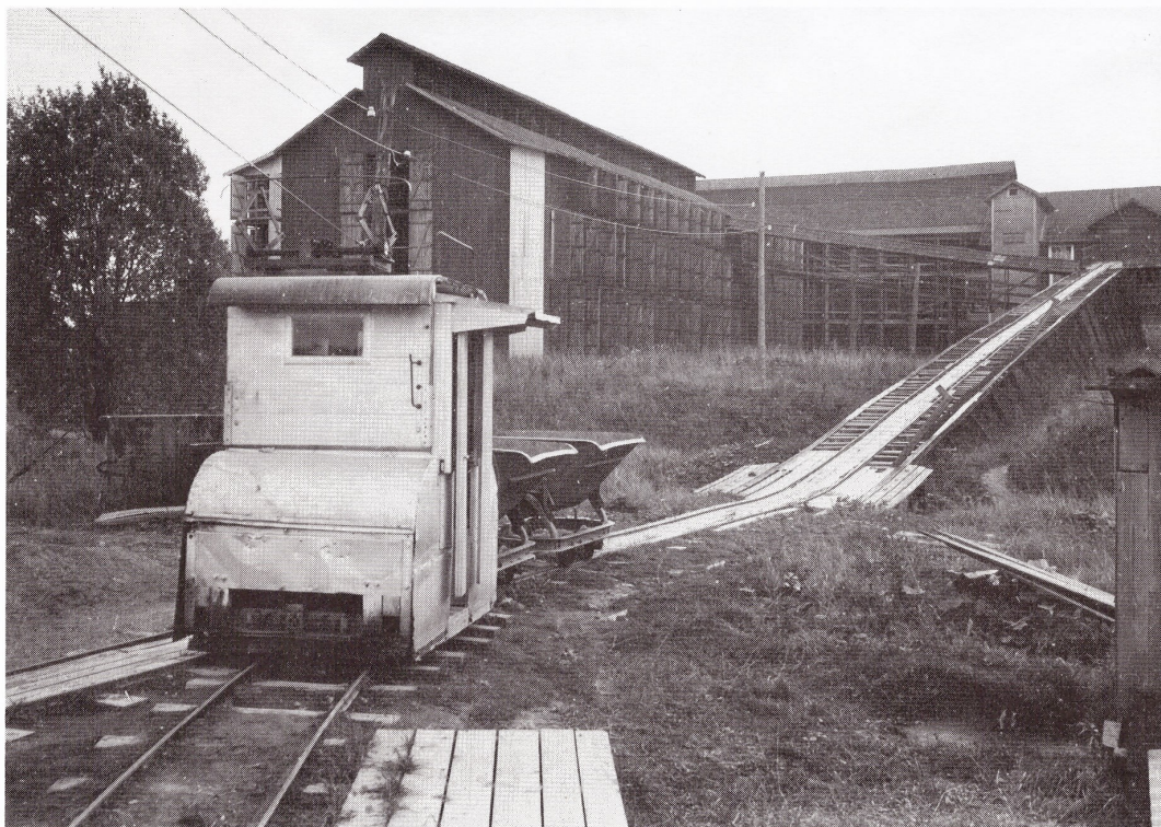
De rälsgående vagnarna med tegellera drogs från lertaget in till själva tegelbruket med ett litet ellok. De stora byggnaderna i bakgrunden är torkklador för råtegel.
