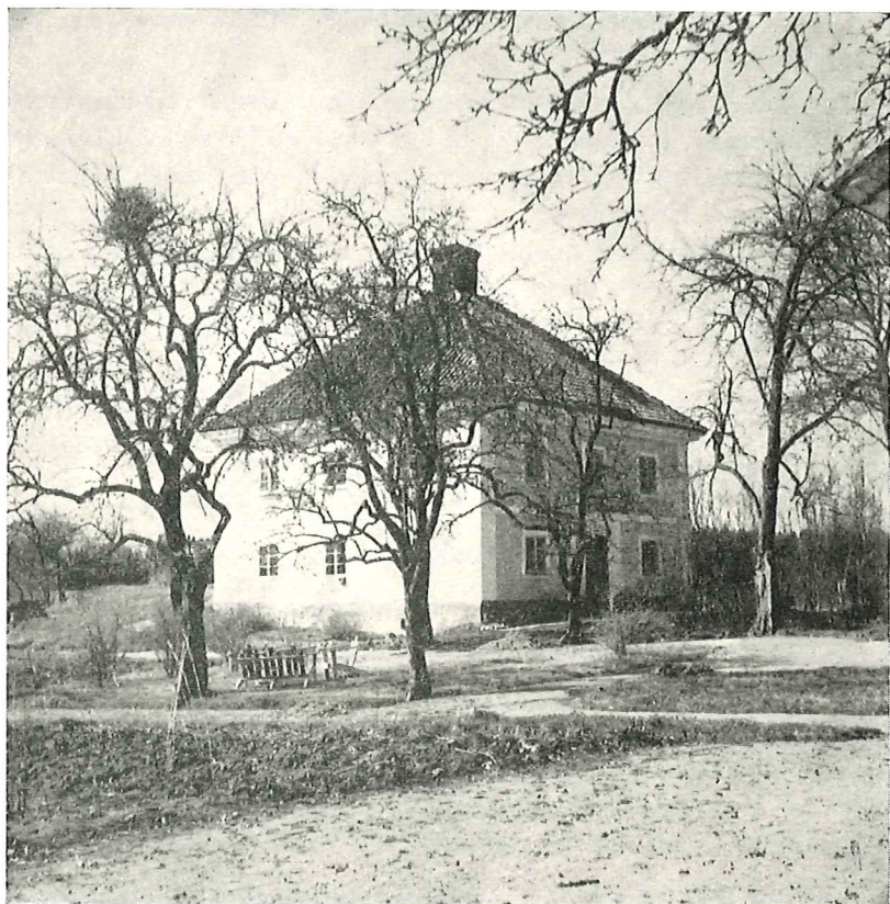
Stensjö var före Katrineholm bygdens centrum. I denna byggnad, då tingshus, bildades 1850 Oppunda Härad's Sparbank
