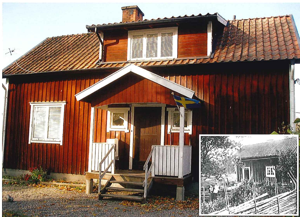
Torpet borta. Nytt bostadshus byggt 1906. Kallas Heden. Beläget cirka 1,5 km nordost om stationshuset. Infälld bild: gamla torpet.
