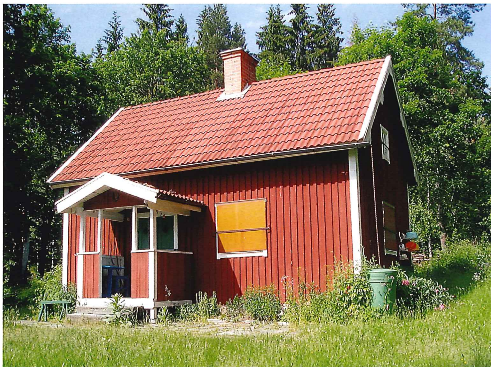
Torpet återuppbyggt efter mordbranden 1826. Beläget väster om och nära vägen Strångsjö-Forssjö.
