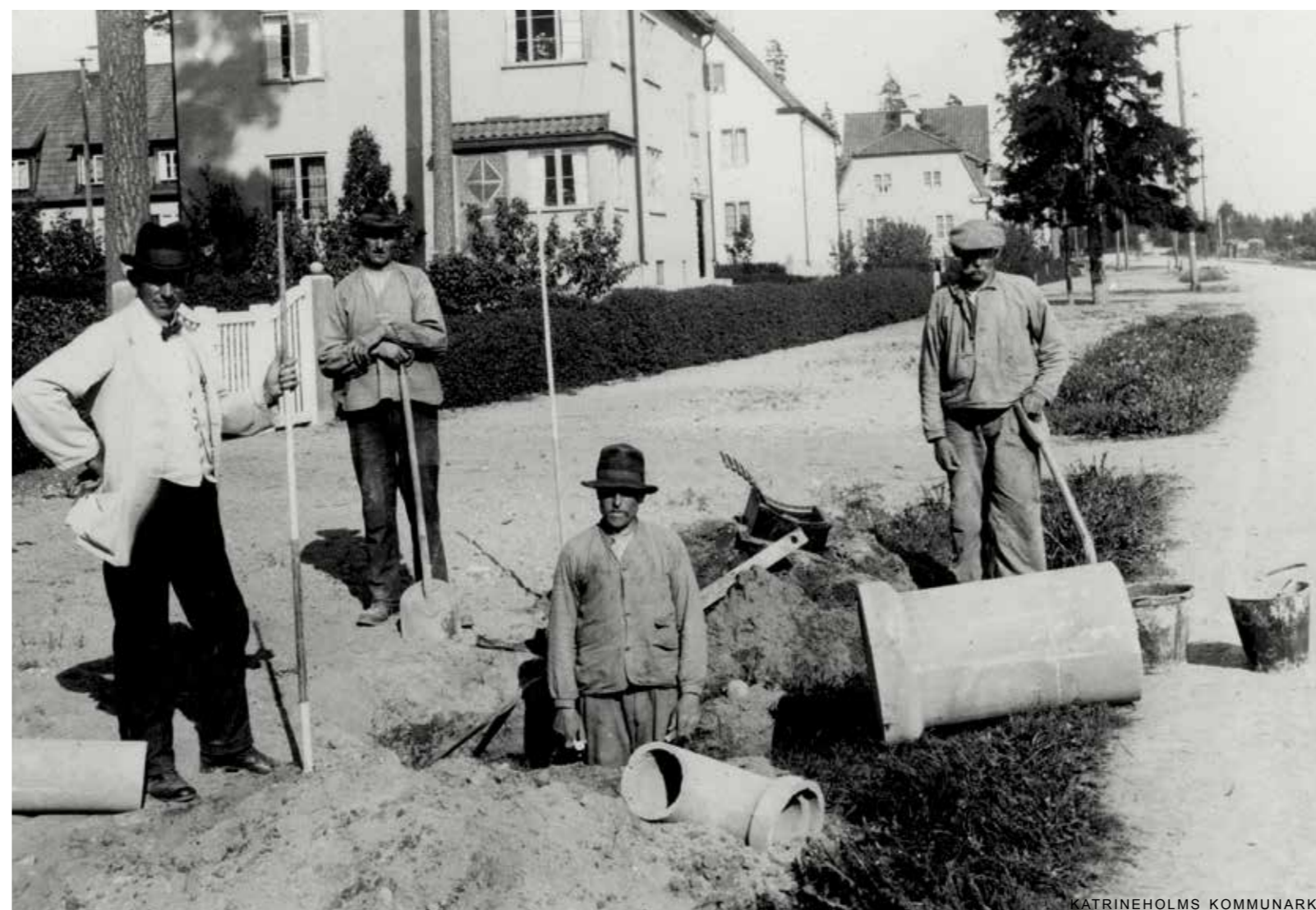
Vattnet skulle inte bara komma in, det skulle ut också. Ett nät av avloppsledningar byggdes, som här vid Oppundavägen 1924.
