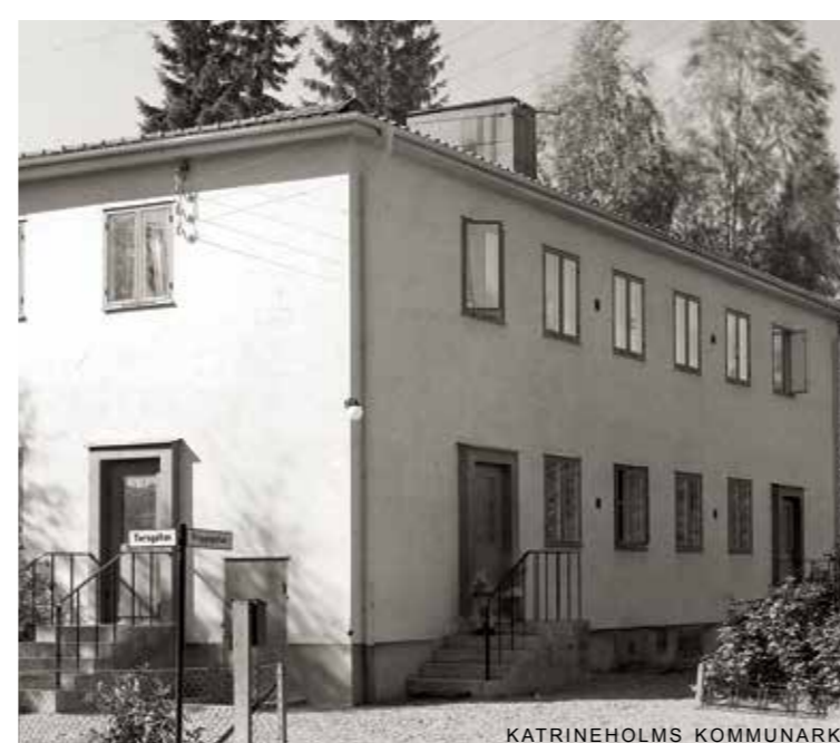
Barnrikehus vid Friggagatan-Torsgatan, 1939. Här finns 16 lägenheter om två rum och kök, utrustade med centralvärme, toalett och badrum.
