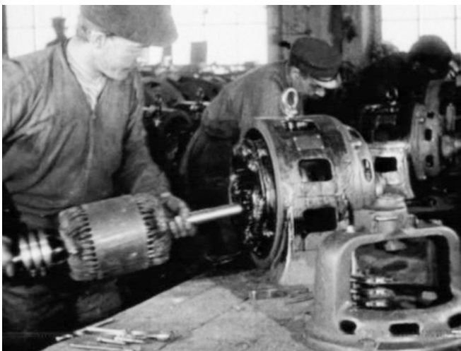
En scen ur en film om ASEA 1918 visar montage av en ASEA motor.
