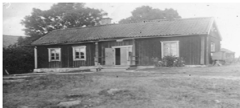
En typisk mangårdsbyggnad
