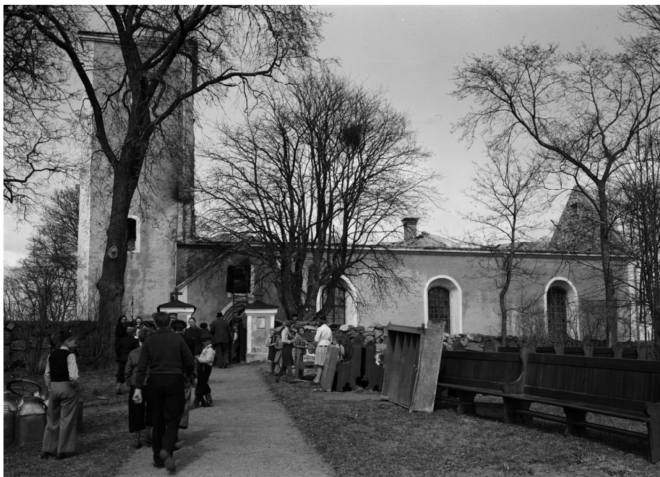
Odensala kyrka efter branden utan tak på långhuset och tornets tornhuvud.
