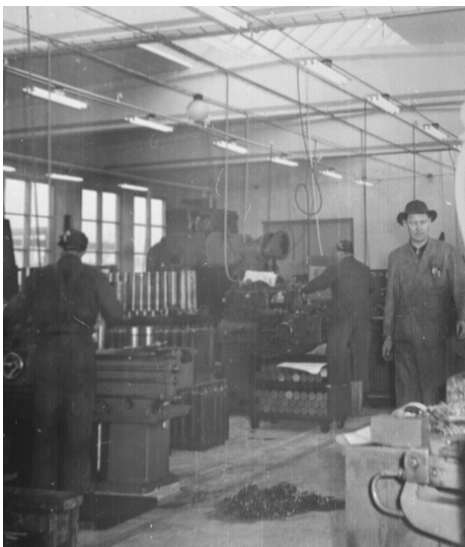
Tillverkning av hydraulcylindrar i maskinverkstaden. 1950-talets mitt.
