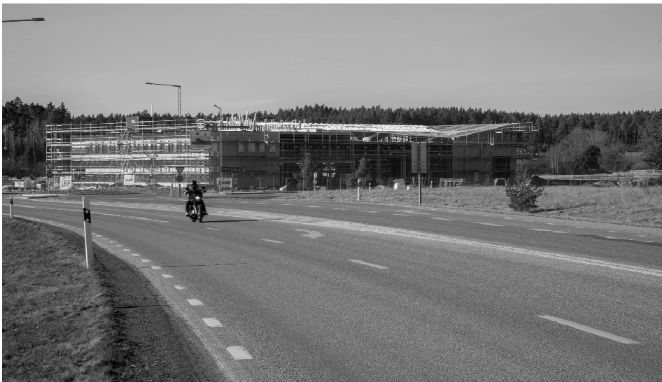
Det byggs febrilt vid Tullen. Den nya brandstationen ska vara klar till hösten.
