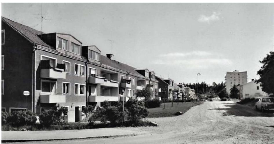
Sätunavägen med den flyttade barnavårdscentralen till höger
