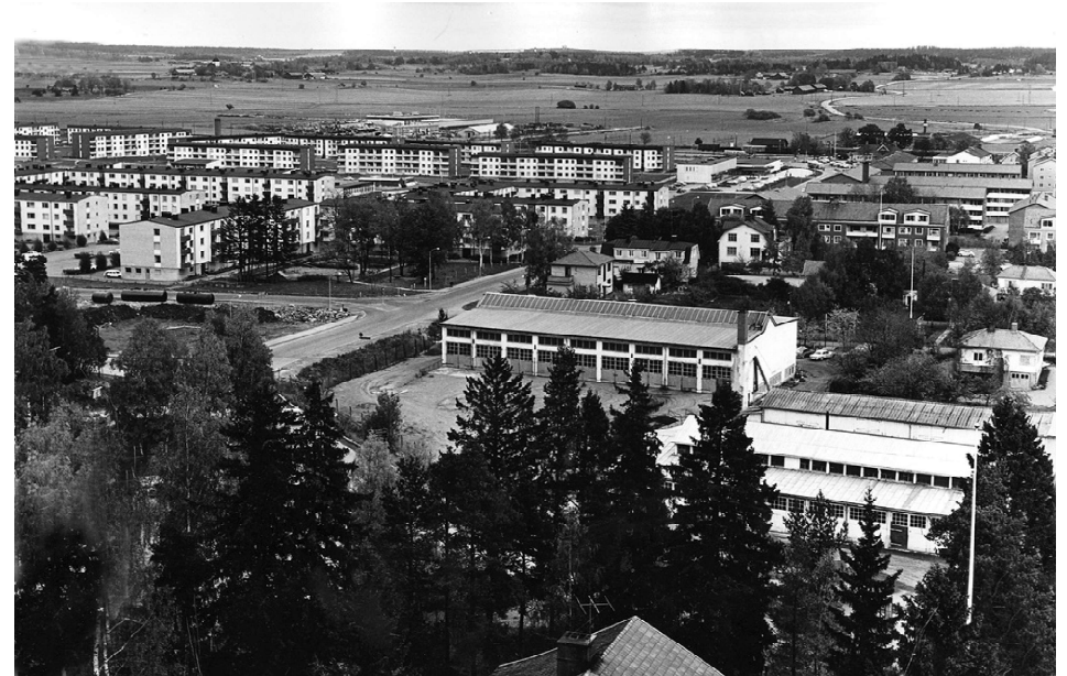
Bakom Sörlings verkstäder fick "Janssons" sin nya placering. Strax framför ligger Hedlunds slakteriaffär (som senare blev "Presenten") och bakom ligger Rönnsäter som fortfarande finns kvar. Till vänster bygger Texaco en bensinstation, som numera heter Preem.
