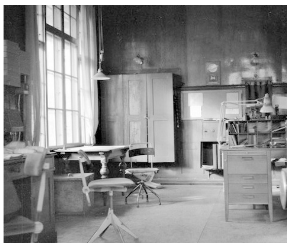
Bakom dörrarna på väggen fanns postluckorna mot väntsalen och till höger biljettluckan.
