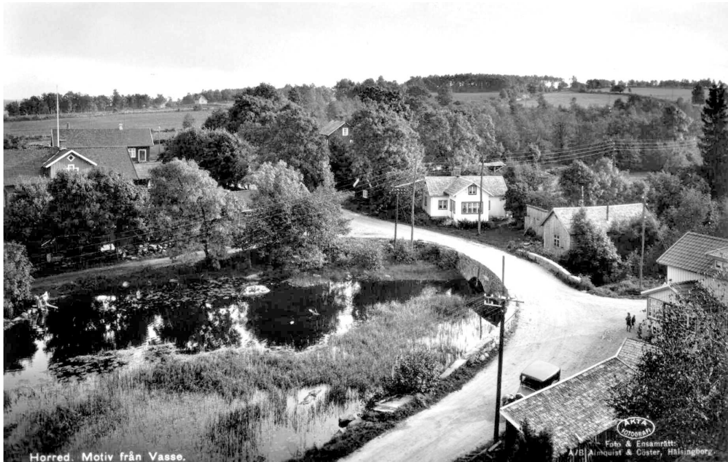
Horred. Motiv från Vasse. Vasse damm med bron och den gamla landsvägen Varberg-Borås. Till höger gamla Helsjövägen. Längst till vänster ligger Västbo och där bakom Börjessons ladugård. Till höger om vägen överst den s.k. statarlängan sedan torpet Hannas. Det vita huset var var Edvin Johanssons och till höger hans snickeriverkstad. Ner till höger Erik Johanssons bostad, från början skola. Foto: före 1936.
