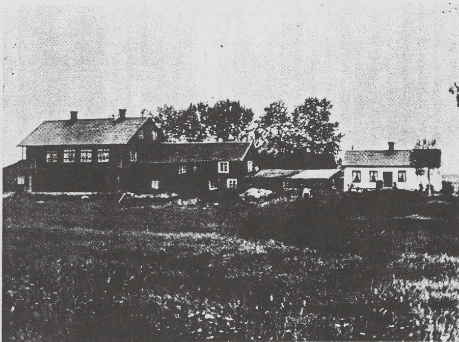
Garvargården i Vibro. T. v. garveribyggnaden med ett tillbygge längst t. v., som sannolikt inrymt några kar. En yttertrappa har funnits under altanens högra del och har mynnat i dess högra ände. Den lägre byggnaden i mitten har med säkerhet använts inom garverirörelsen och torde ursprungligen kunna ha varit en äldre garveribyggnad. Det låga skjulet innehöll grisstia, ladugård (garvare Sandberg hade tidvis en ko) m. m. Den vita byggnaden t. h. är det äldre boningshuset. Bakom skjulet skymtar det boningshus, som Sandberg uppförde, då han blev sjuk, och bebodde sitt sista levnadsår.
