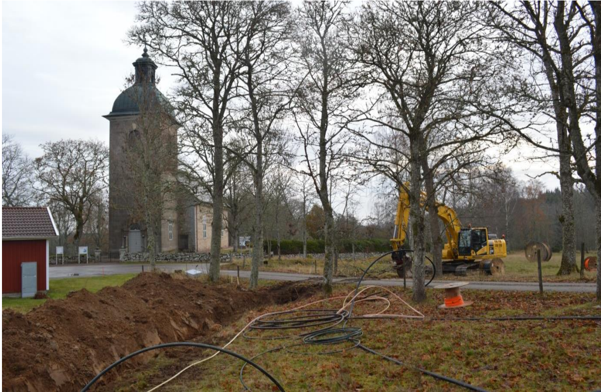
Kyrkan står stadigt trots slangar och maskiner
