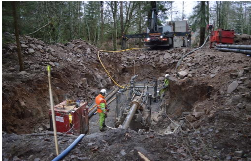
Borring under väg
