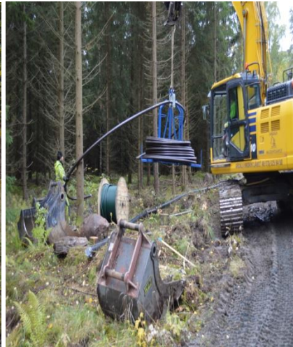
Utläggning av ledningar
