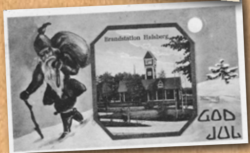
Ett julkort med Halls- bergs brand- station.
