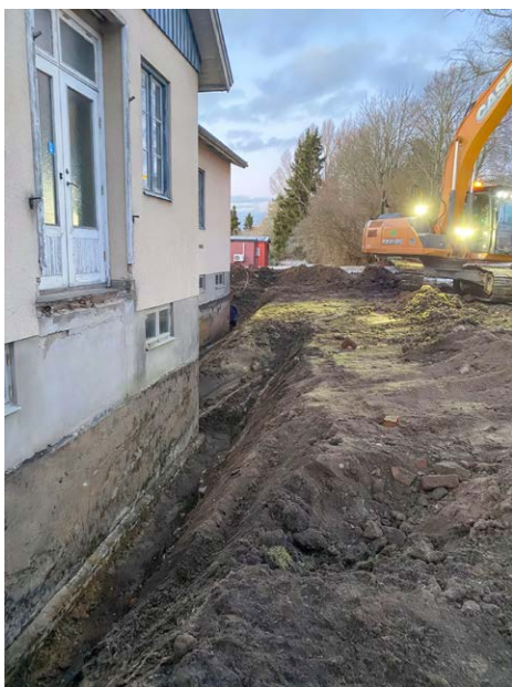
Östgöta Björnschakt har rivit den gamla trappan och grävt för dränering. Sen ska ytor för parkering och gångväg markberedas innan vintern. Asfaltering får ske i vår.
