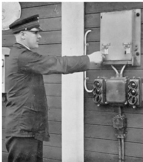
Reglering av signaler vid Prästköps station.
