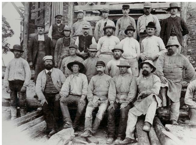
Arbetslag vid kyrkbygget 1893 - 1895.
