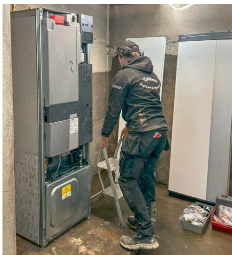
Tjällmo Vatten & Värme installerar värmepump och monterar nya radiatorer.
