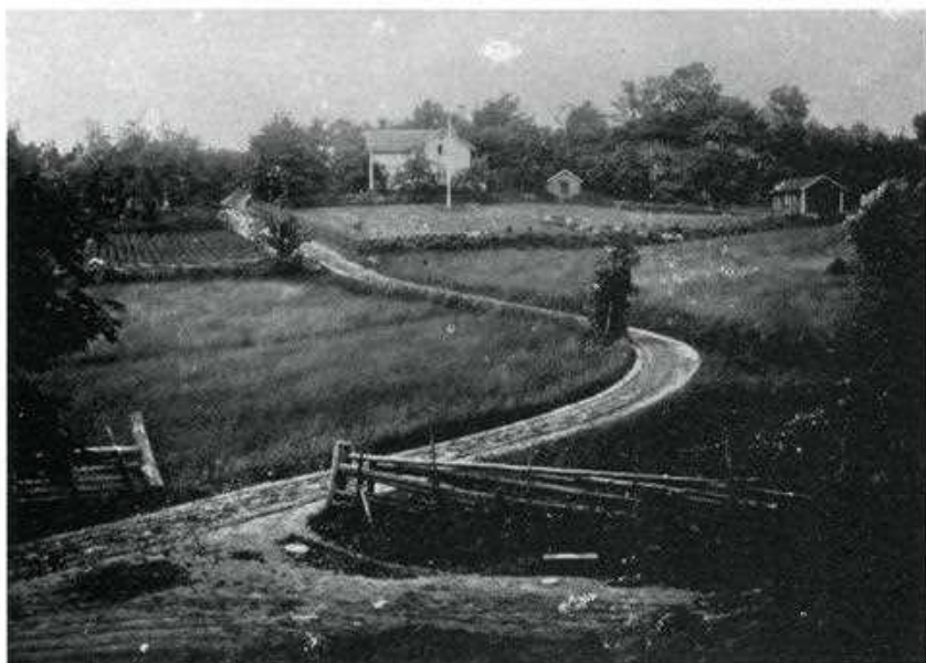
Marieberg före sista ombyggnaden.
