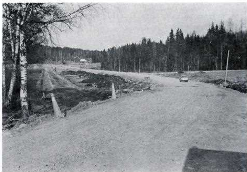
Vägen under ombyggnad 1978. I bakgrunden Soineryd.
