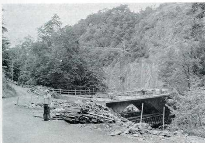
Nedre bron under byggnad. Foto: Evert Andersson.
