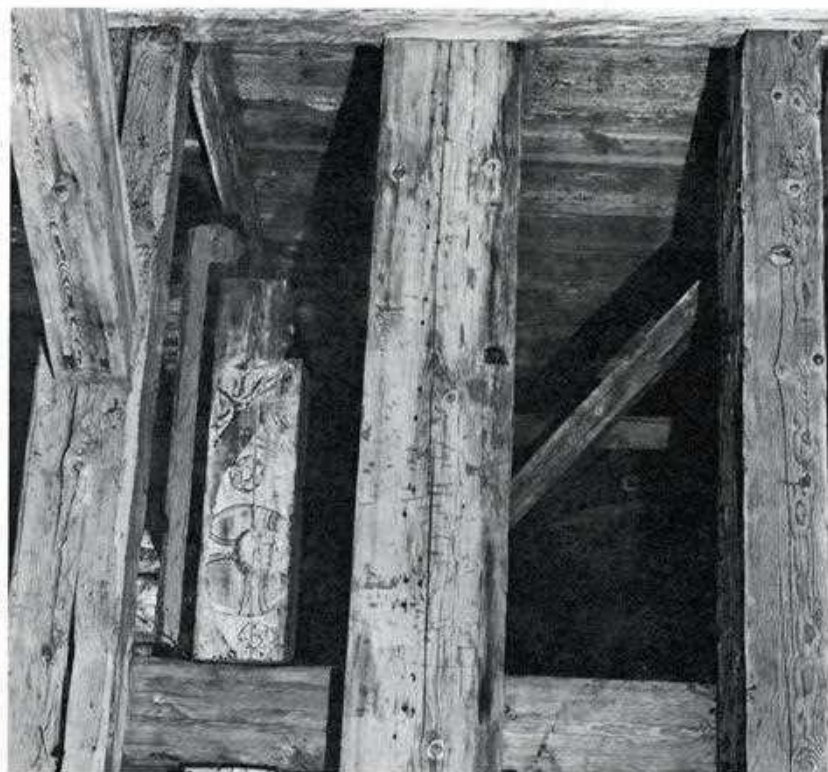
Takkonstruktionen med målade och omålade bjälkar uppe i tornet.
