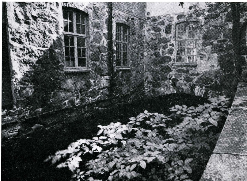
Stensholms fabrik: Granitmurar som delvis stammar från 1700-talets pappersbruk. Till höger synes ett stenvalv som är slaget över kanalen och sträcker sig 5—6 meter in över vattnet fram till en gammal turbin, där förut vattenhjulen fanns. I fabriksväggarna finns huggna granitstenar, som tidigare tillhört något annat byggnadsverk (sannolikt Stensholmens bebyggelse). Även i valvets tak finns många stenar som är sekundärt använda. Foto H.B.
