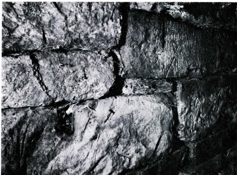
Foto mot taket i kanalen. Här ser man stenar, som är huggna för annat ändamål. Märk stenen ned till vänster, som är försedd med urtag för låskolv i dörr. Stenen till höger är delvis finhuggen. Foto H. B.
