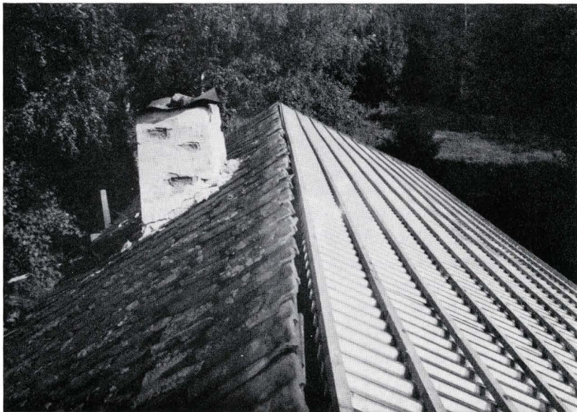
Klinten med halva aluminiumtaket monterat. Foto Harry Bergenblad.
