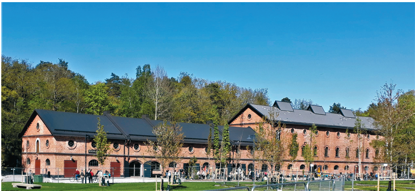
Svavelsyrefabriken våren 2020. Marksanering pågår. Foto: H. Jungnell
