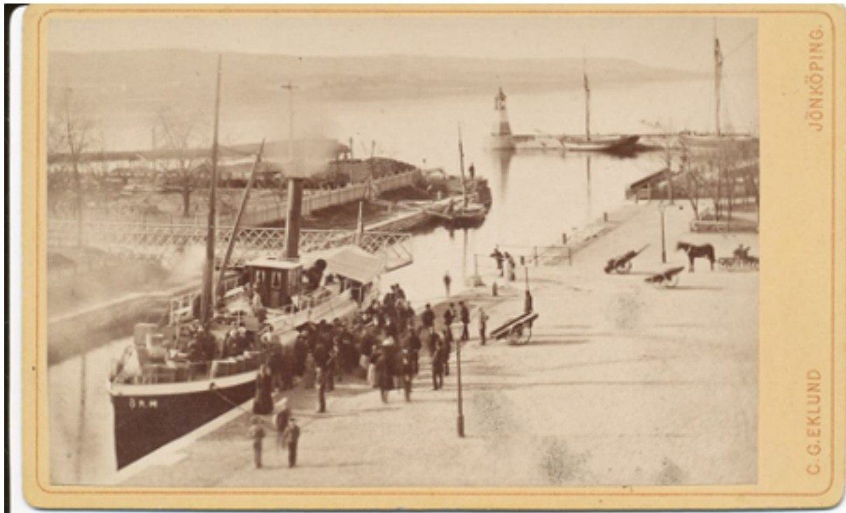
Bild 1 Notera att järnvägsbron, en svängbro är öppen. Bron i Järnvägsgatans förlängning finns inte
