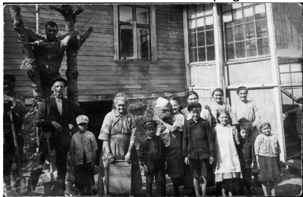
Hyresgäster framför stora huset Åsensvägen 70, Omkring 1920.
