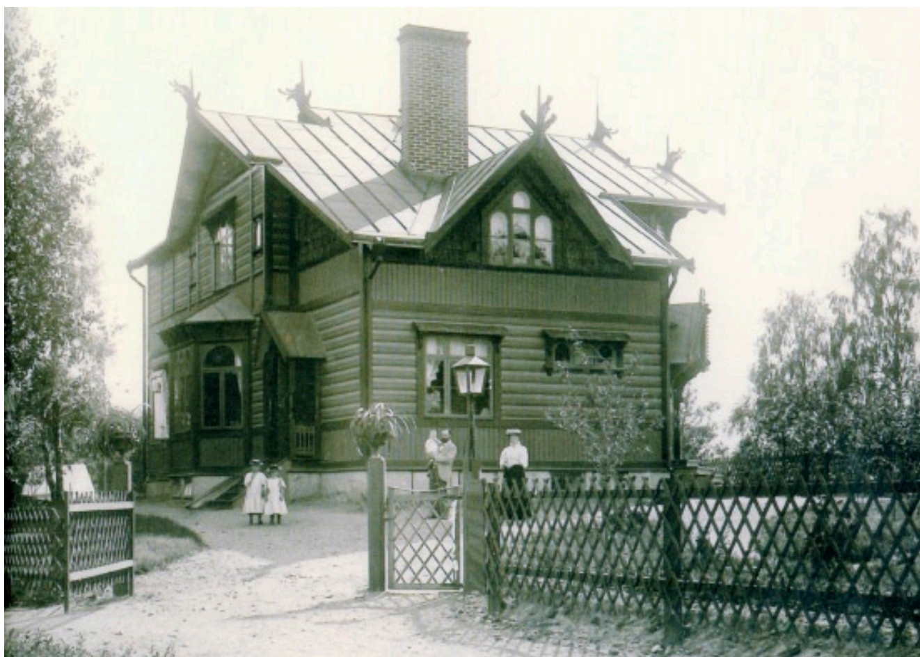
Exempel på monteringsfärdigt hus byggt av Katrineholms Snickerifabriks Aktiebolag. Husets beställare, apotekare Curt Kullberg, fotograferad framför huset. Huset uppfördes 1895 och bilden bör vara tagen åren därefter. Huset ligger idag kvar på adressen Storgatan 6 i Katrineholm. Foto: Katrineholms kommunarkiv.
