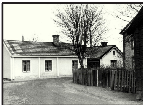
Guldsjärskvarteret 17, intill Söderbergsgården.
