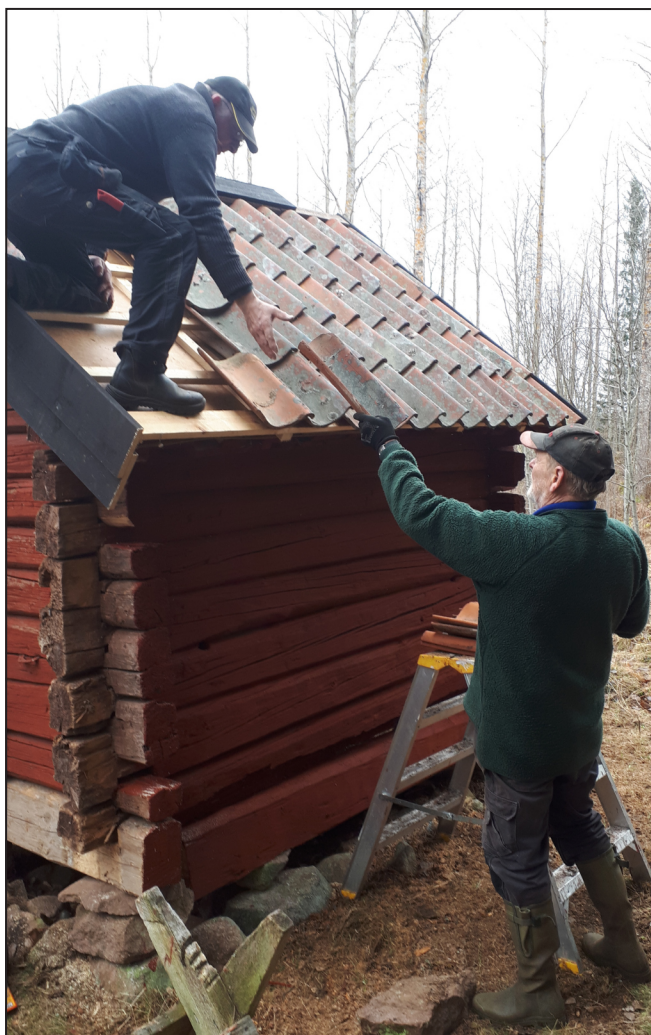
Anders och Bengt lägger de sista tegelpannorna.
