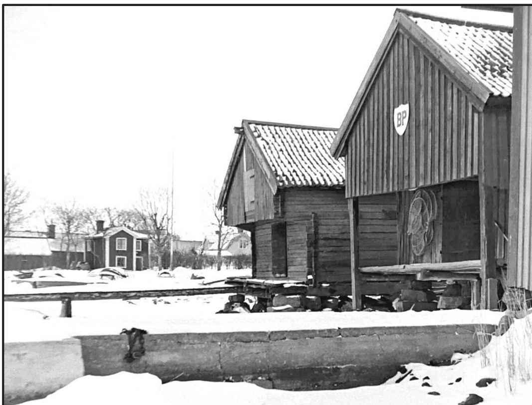
13. Hamnmagasinen vid Sjötullen på 1940-talet. I magasinen förvarade handlarna sina varor, som vanligen kom med båt.
