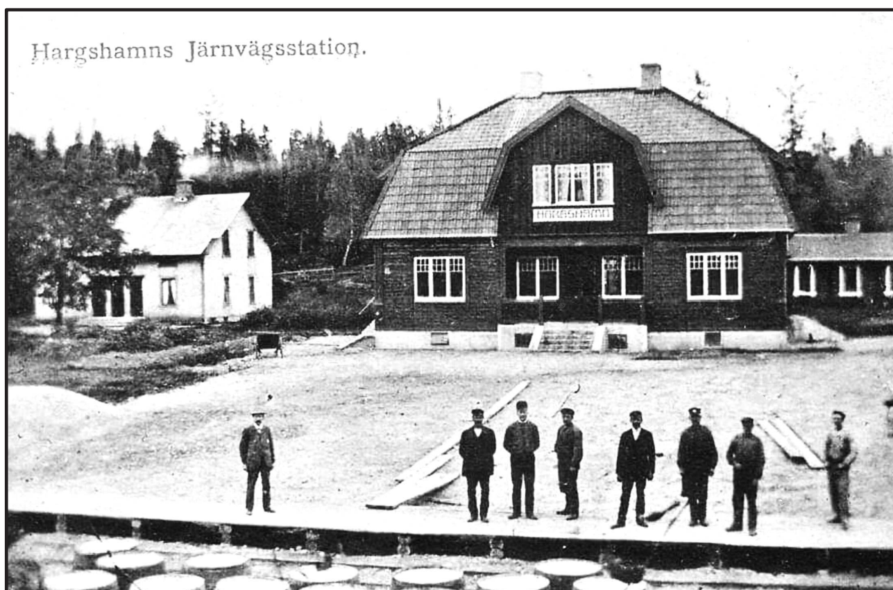
Hargshamns järnvägsstation 1910. Gamla och nya stationshuset.
