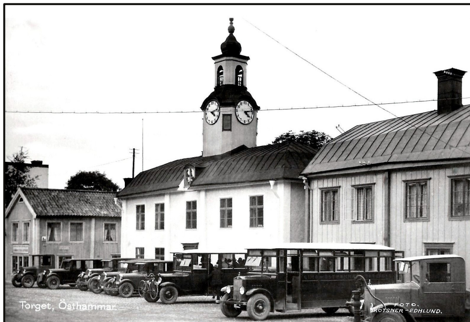
Torget ca 1927. De första bussarna från 1923. Till höger busstationen som revs 1948 och återinvigdes 1950. Huset längst till vänster Wilkessons fastighet, revs 1942 för att bredda gatan mot Sjötorget.
