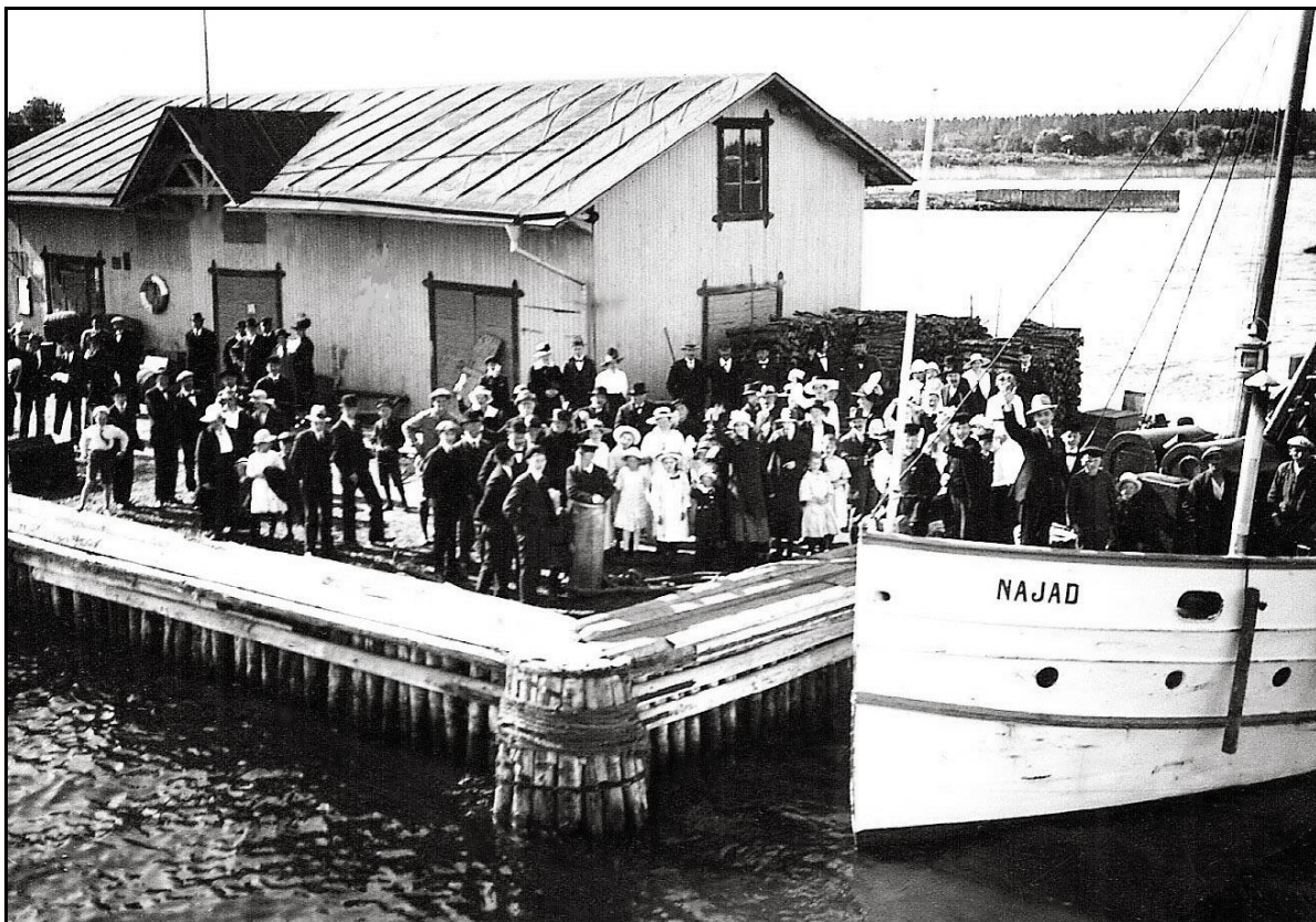
När båtarna låg vid kaj samlades många åskådare, här en bild från ca 1920. Bakom Hamnmagasinet skymtar den vägbank som man börjat bygga ut mot nuvarande varvet och campingen!
