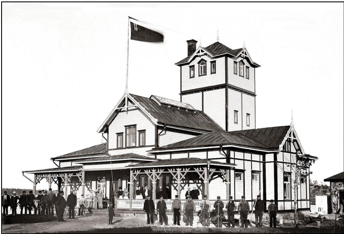
Det äldsta varmbadhuset brann ned 1897 och ersattes av ett nytt som invigdes 1898. På bilden ser vi det nya badhuset bland de hantverkare som arbetat med bygget. Huset revs omkring 1957.
