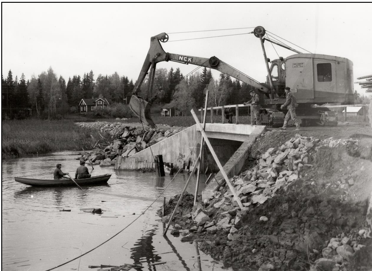
I mitten av 1960-talet uppfördes den länge efterfrågade Husbackabron, som knöt ihop Östhammar med Söderön. Bron breddades under 2015.
