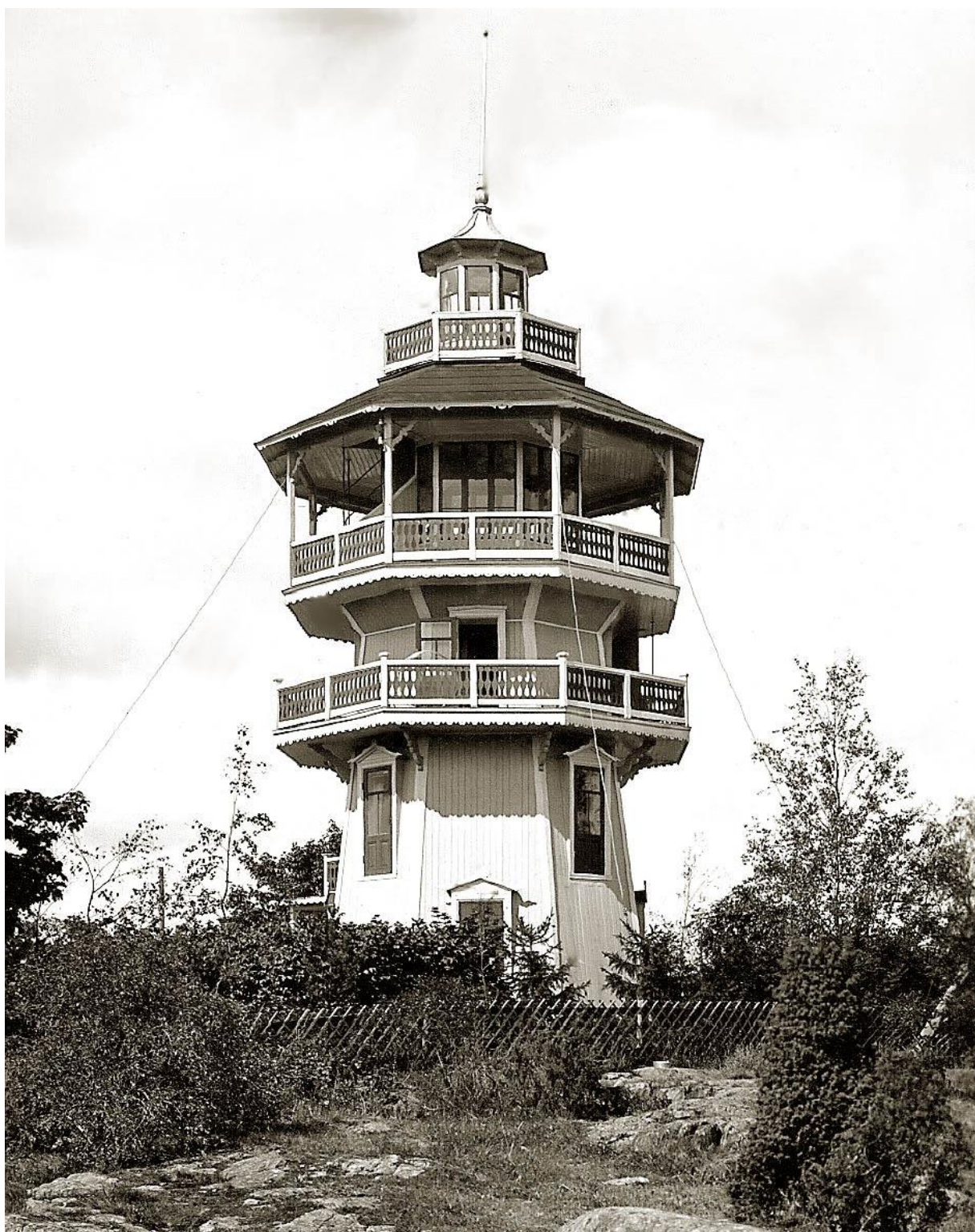
På berget ovanför Badhusparken stod under många år det här dekortativa utsiktstornet. Det öppnade sommaren 1902 och erbjöd fem uthyrningsrum med balkong samt glasad servering med vidsträckt utsikt. Tornet var tidigare en väderkvarn av s k holländsk typ, dvs kvarnets överdel med vingar gick att vrida mot vinden. För ombyggnaden svarade Kvarnens ägare, rådman Mathias Lundqvist som också drev Östhammars Ångsåg där panel och snickeridetaljer tillverkades. Tornet revs 1942.
