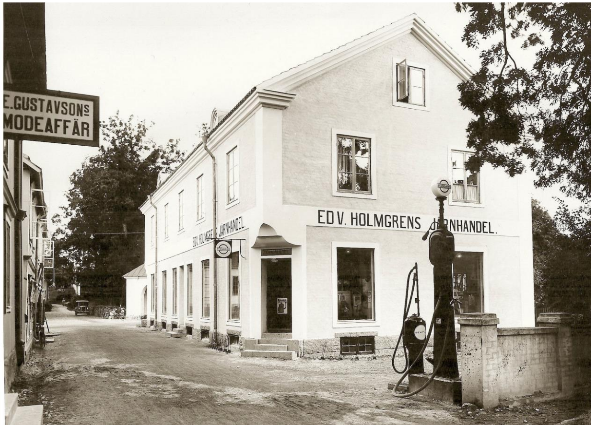
Järnhandlare Henric Janssons rörelse inköptes senare av Edvard Holmgren. Han uppförde 1927 ett nytt hus i cementsten, s.k. Poolsten som han själv lät tillverka i ett hus vid Rådmanngatan. Här ser vi det nybyggda huset som ritats av byggnästare Carl Brunnström. Modeaffären t v drevs vid denna tid av Elin Gustafsson.
