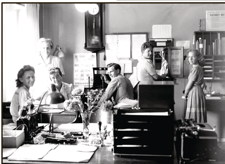
Interiör från det nybyggda Post- och Telegrafhuset på Prästgatan 3. Telegrafstationen med telefonväxel var en stor arbetsplats fram till automatiseringen av stationen 1964. På bilden som är från början av 1940-talet ser vi längst t v den nyligen bortgångna Dagny Bohlin (Lemberg)
