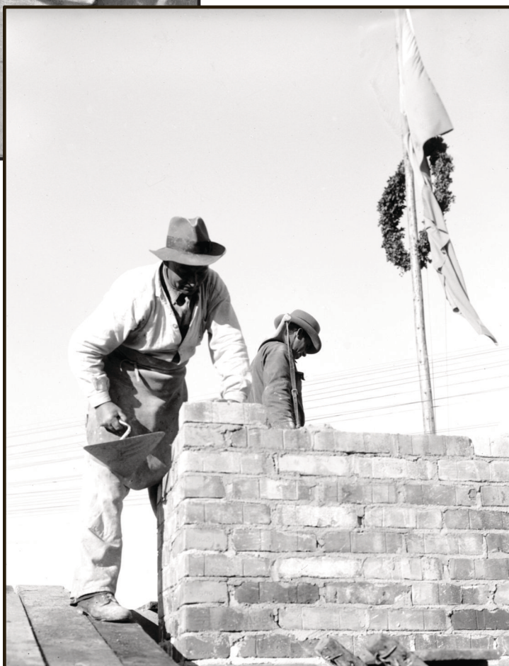
Taklagskransen är hissad på IOGT:s ordenshus Storbrunn 1935. Här arbetar två murare (okända) med att färdigställa skorstenen.
