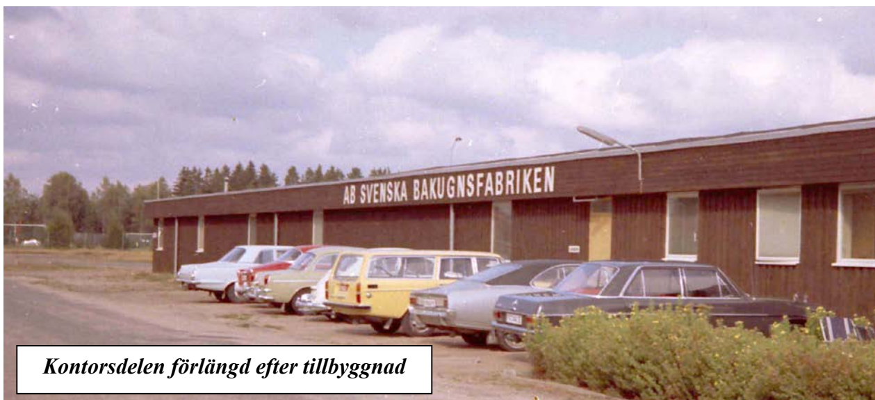
Svebas verkstadsbyggnad med den bruna kontorsdelen till höger Bakom kontorsdelen skymtas SJ:s godsmagasin på andra sidan järnvägen
