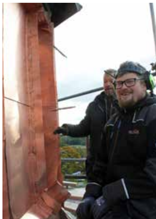
Martin och Anton viker kopparplåtar i plåtslageriet i Tranås. På bilden till höger är de på plats i kyrktornet Frinnyrd och monterar dem.
