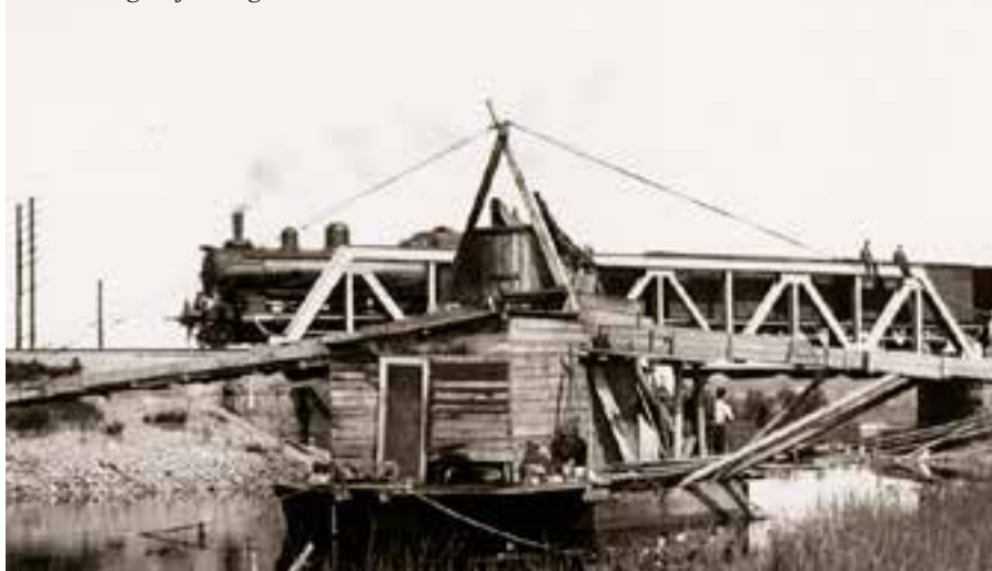
Renovering av järnvägsbron över Svartån 1912. Foto: Oskar Jarén
