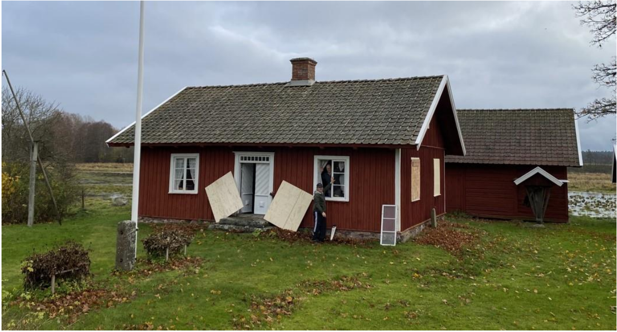
Vi hade sågat till plywoodskivor som vi täckte för fönstren med då vi arbetade med fönsterrutorna
