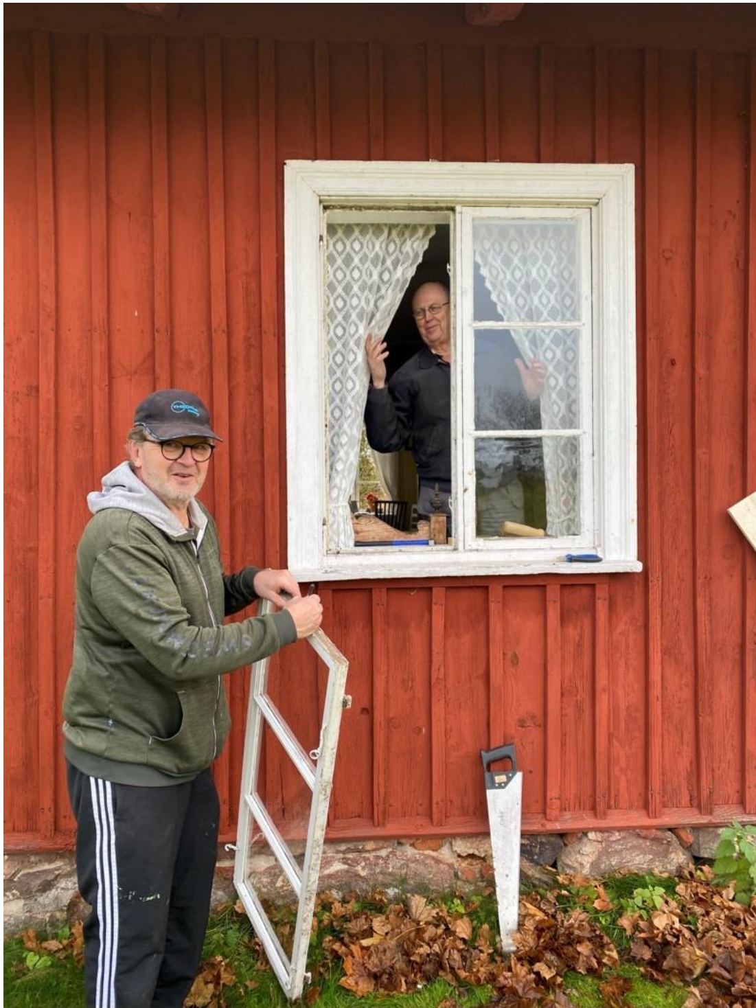
Här håller vi på med att plocka ut fönstren
