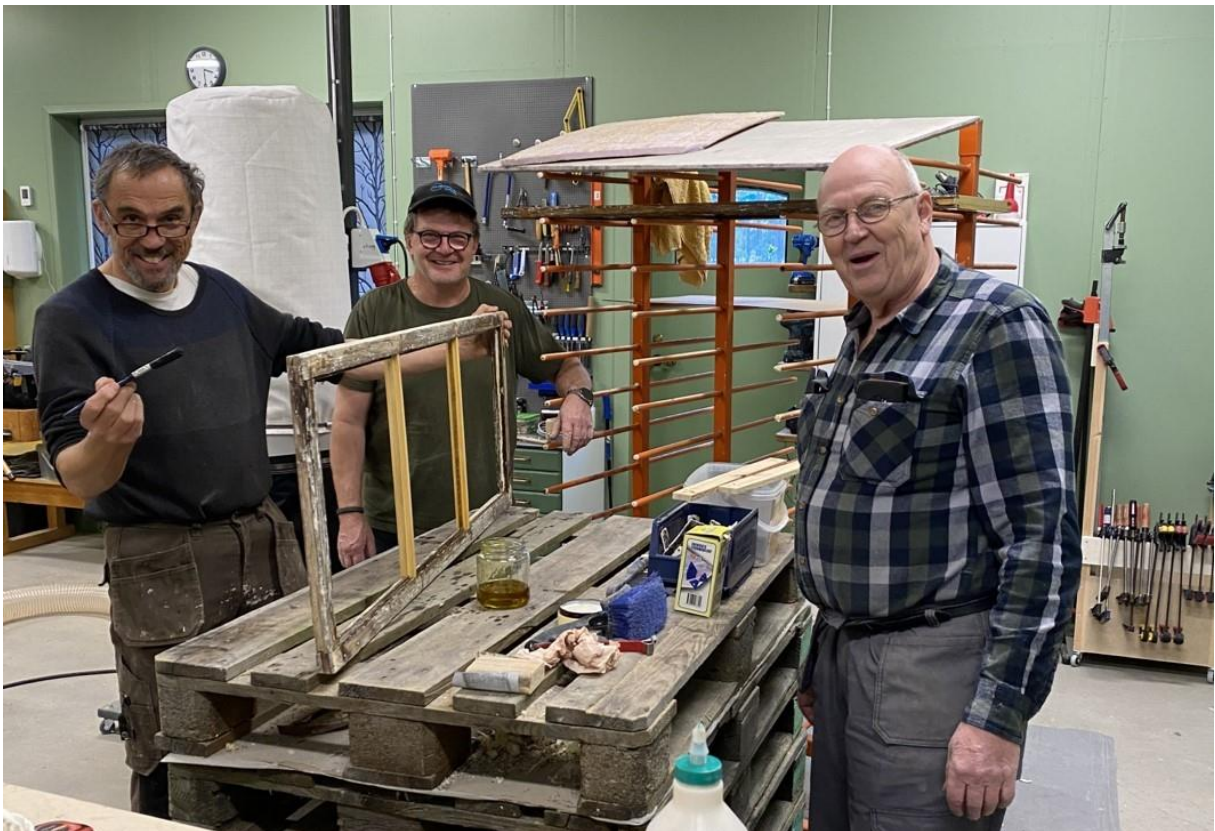
Här en bild från Håkans ”snickebo”. Stellan oljar in fönsterramen efter att Håkan har tillverkat och bytt det virket som var så dåligt att det inte gick att använda.
