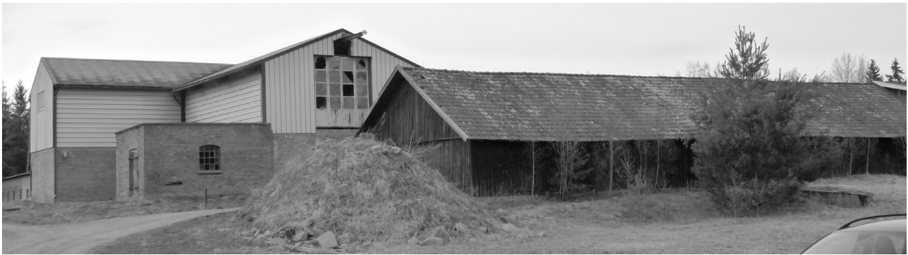
Det är drygt 50 år sedan tegelproduktionen stannade av på Annefors tegelbruk men byggnaden finns ännu kvar. I förgrunden ses den byggnad som användes som lager för taktegel. Foto: Lena E Jonsson.
