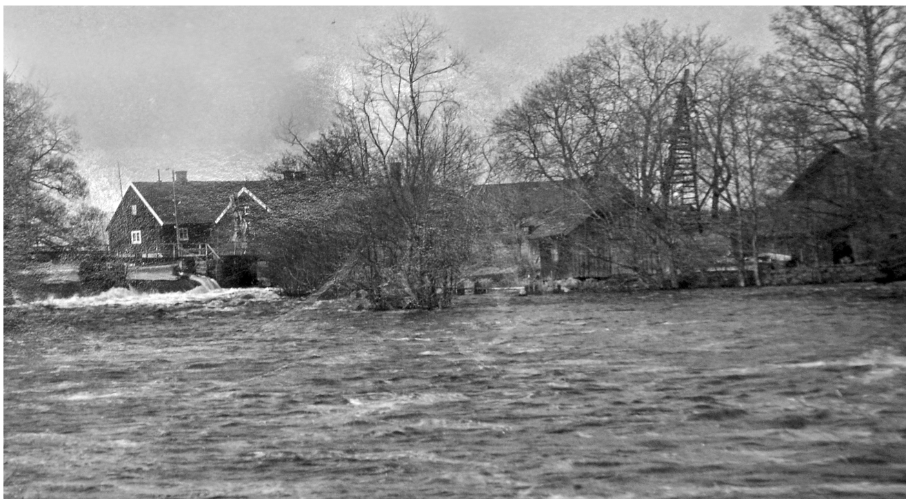
En ganska unik bild, tagen nedanför det andra dämnet i Annefors. I bildens mitt ser vi gavlarna på Brukarstugorna. Till höger utmed åkanten finns flera större och mindre byggnader. Mellan dessa ses ett torn med två hjul, detta är en del av det linspel som drev ler-ältningen i tegelbruket.
