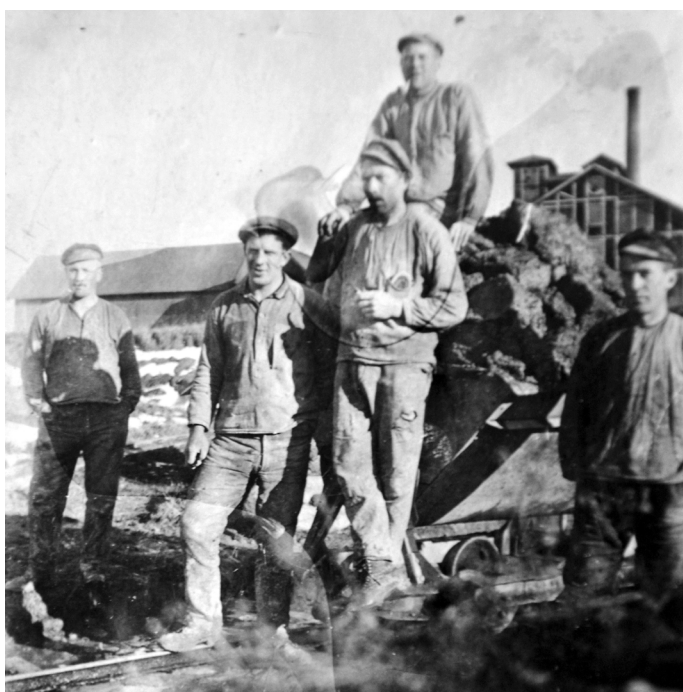
Erik Persson var en av dem som arbetade i det gamla lertaget på samma sida av ån som bruket ligger. Man skar då lera för hand med raka spadar, lastade lerblocken på rälsburna vagnar som sedan "pötades" fram till tegelbruket där de vinschades in.
