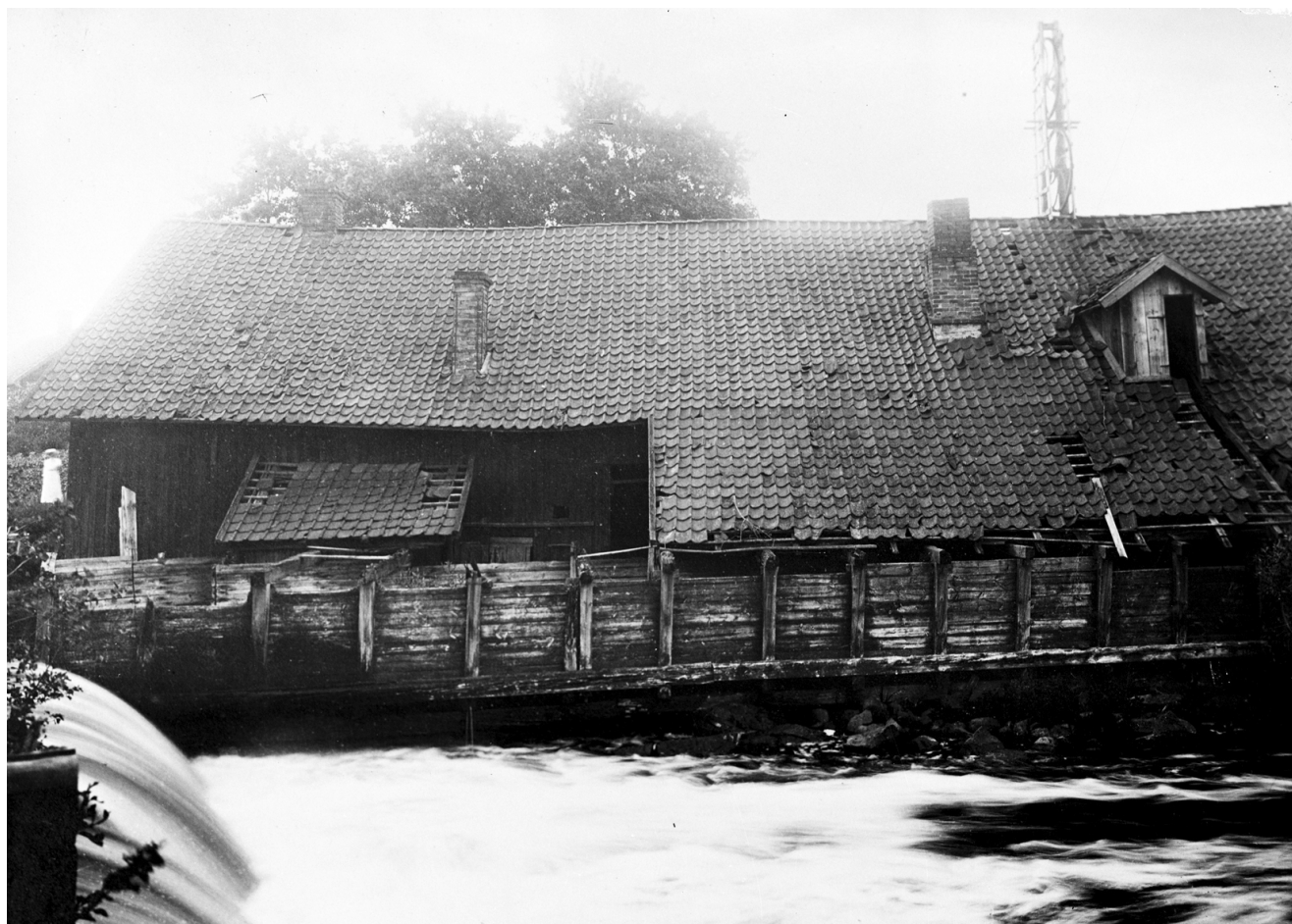
Fotografen Anna Bromander tog 1901 denna bild på den gamla Hammarsmedjan/Spiksmedjan vid Annefors bruk. Bilden visar ränna och hjulhus. Byggnaden var belägen på norra sidan av ån vid övre dammens fall. Ovan taket, i höger kant, ses två av linspelets hjul som överförde vattenkraften till leräلتningen i tegelbruket. Bilden kommer från Västergötlands museum.
