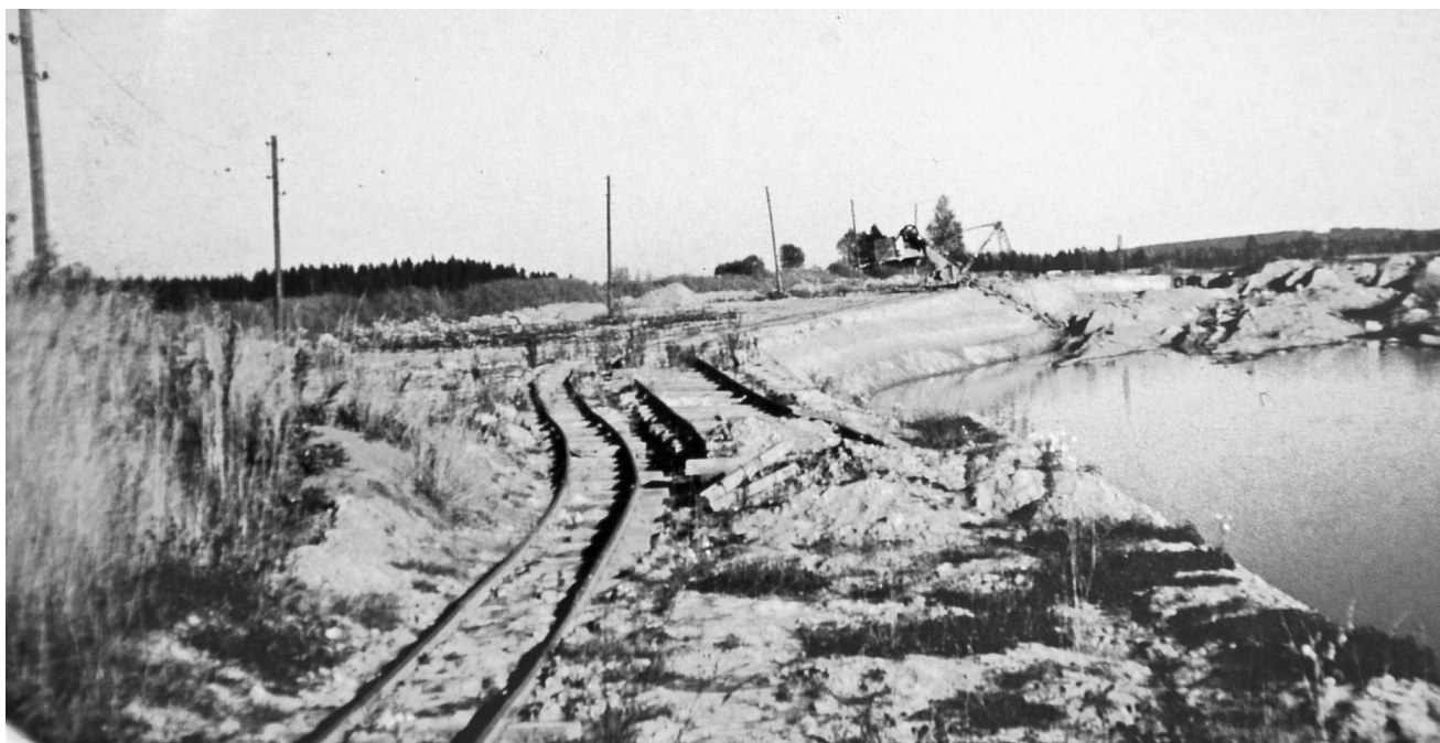
Lertaget på södra sidan av ån fotograferat omkring 1960-1965. I fonden ses den skopelevator som användes för att ta upp leran. Elevatorn gick på räls utmed lertagets kant. Foto: Bo Gyllenberg.
