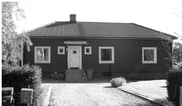
Tegelmästarvillan ligger ungefär mitt emot tegelbruket. Huset är byggt i trä med revetering och stod färdig 1946. Huset inrymde tre rum och kök. De första som flyttade in var tegelmästare Hemlin med familj. Makarna Anders och Hildur Hemlin hade barnen Anna-Britta, Bolla, Anders och Karl-Åke. Foto: Bertil Persson.
