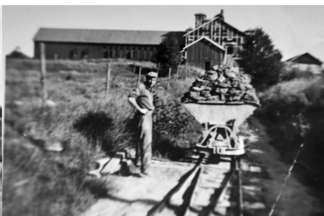
Erik Persson var en av dem som arbetade i det gamla lertaget på samma sida av ån som bruket ligger. Man skar då lera för hand med raka spadar, lastade lerblocken på rälsburna vagnar som sedan "pötades" fram till tegelbruket där de vinschades in.
