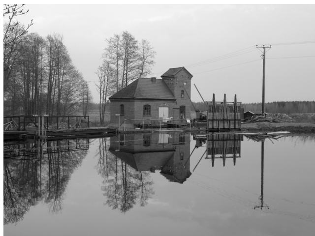
År 1915 installerades en turbin och en likströmsgenerator i det nedre fallet på Annefors. 20 år senare byggdes anläggningen om varvid denna kraftverksbyggnad uppfördes. Foto: Lena E Jonsson.
