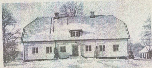
Huvudbyggnaden på Annefors byggd år 1950.
