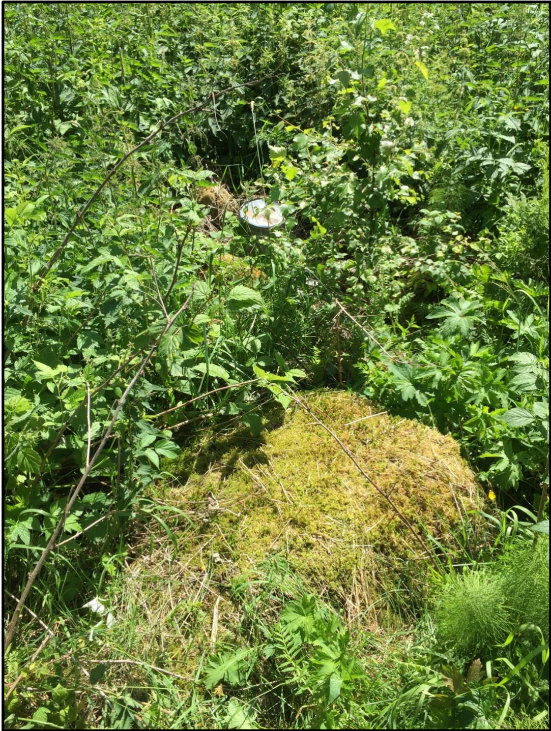
Grävd brunn, stensatt med natursten.
