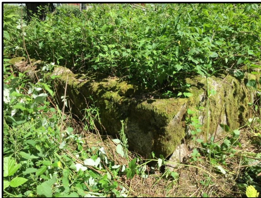
Husgrund av tuktad sten.
