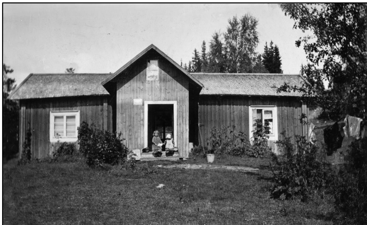
Gamla stugan vid Grönfallet före ombyggnationen 1930-1931. Foto genom Märta Johansson.
