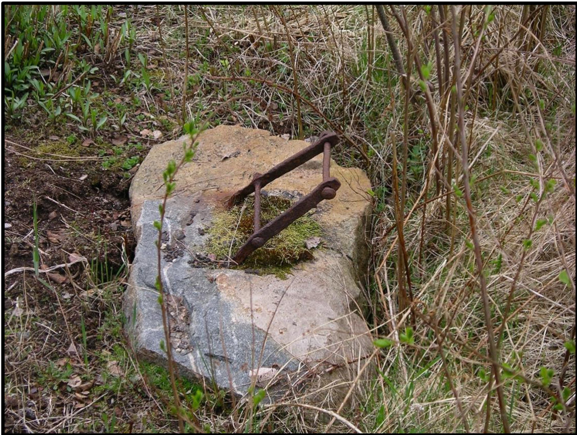
Järnfästen inborrade i sten.
