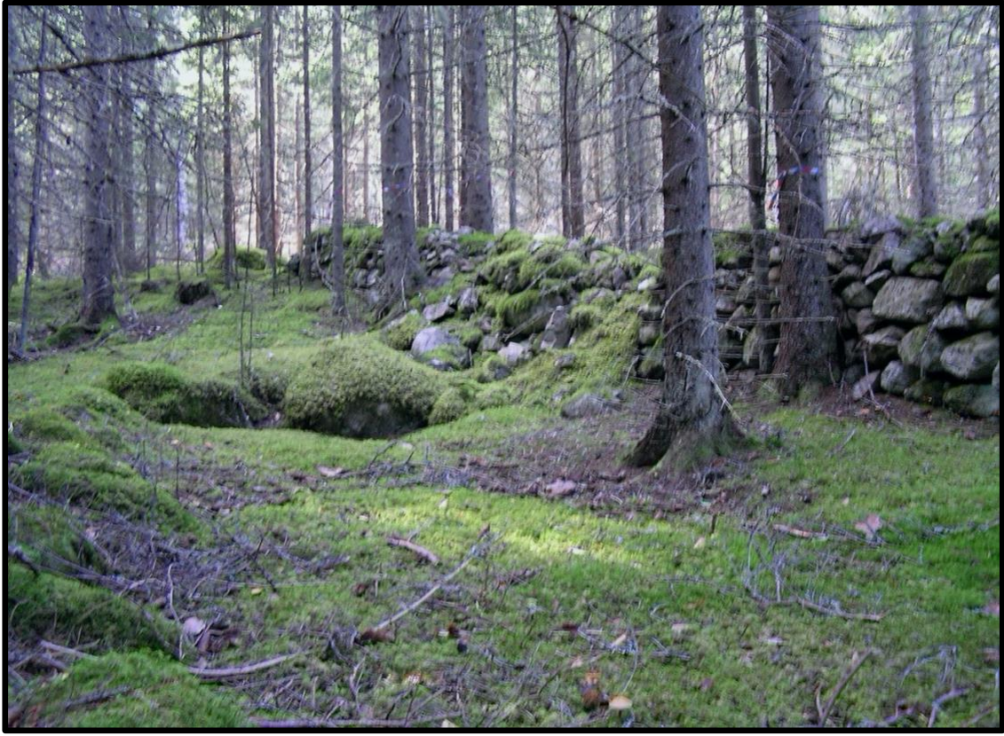
Stenmur, kallmurad av natursten cirka 30 meter.
