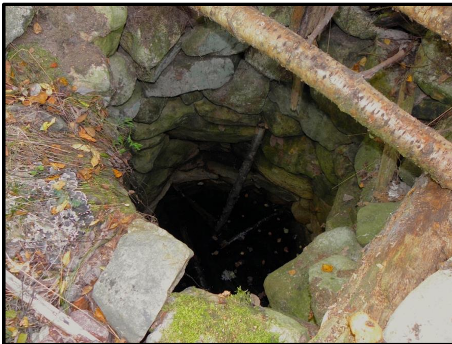
Uppbyggd terrassering av natursten i sluttning, för att därigenom få en plåtå där man kunde stå och använda brunnstången. Djup 2,5 m. till vattenyta.
