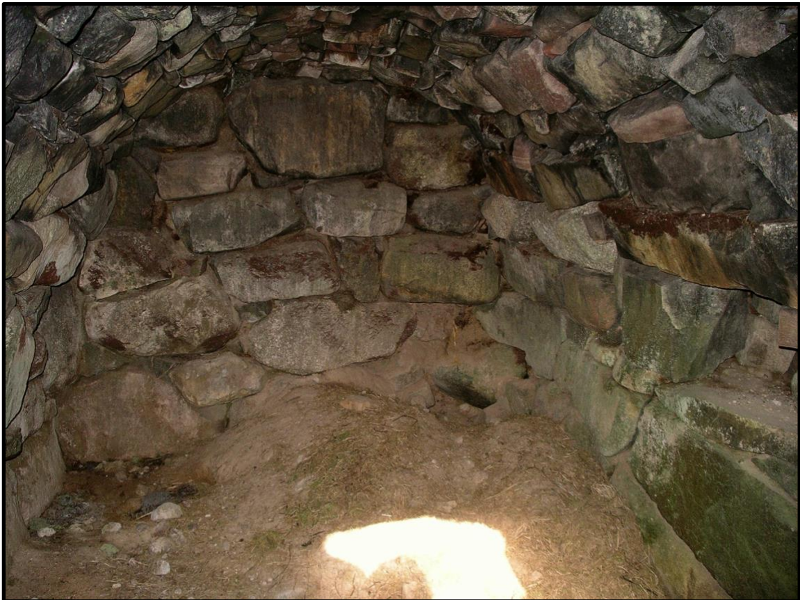
Här ser vi jordkällarens kilstensformade valv av natursten.
