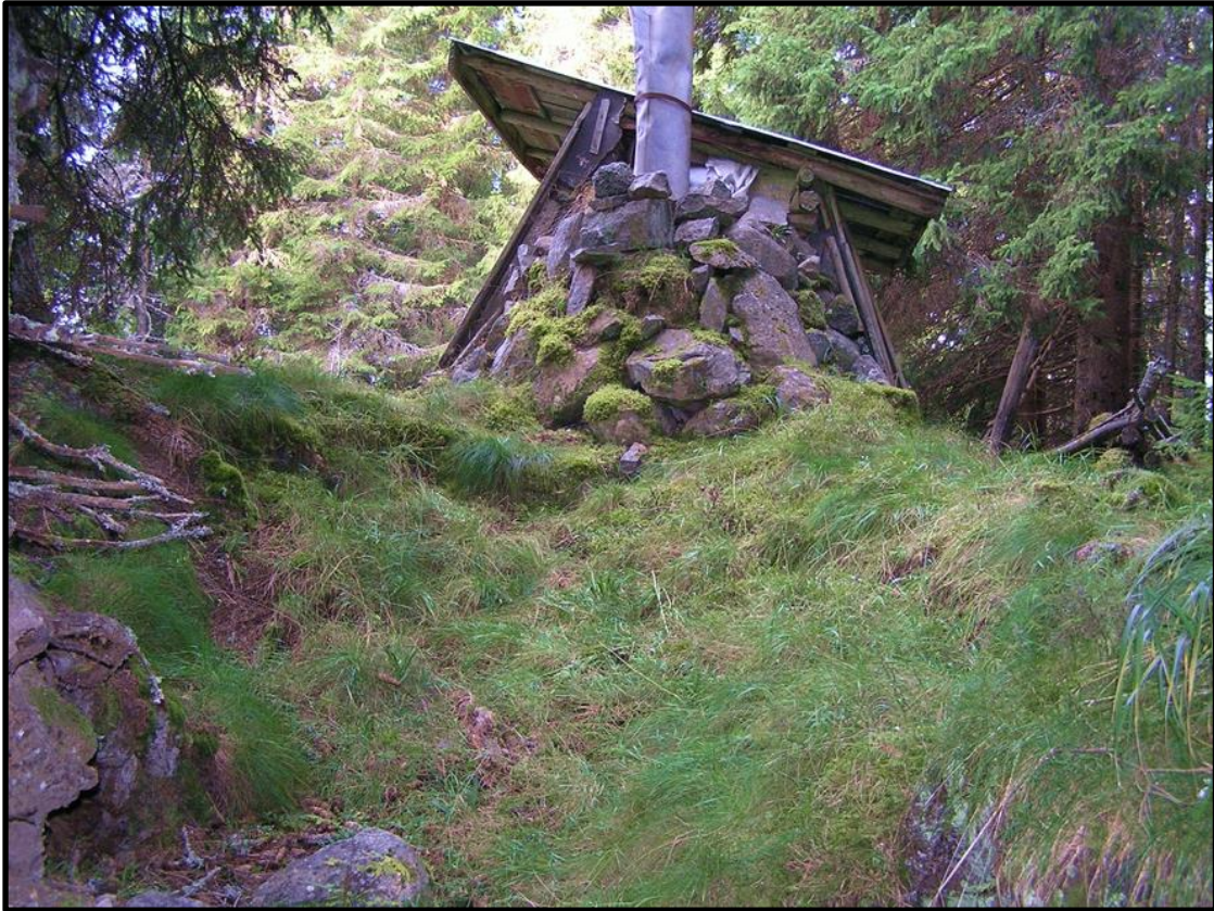
Jordkällaren, med den på senare tid, uppförda kajan i direkt anslutning.
