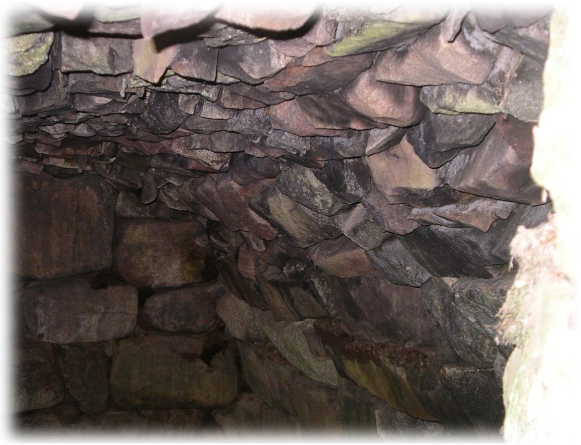
Källaren inifrån välvd av natursten
