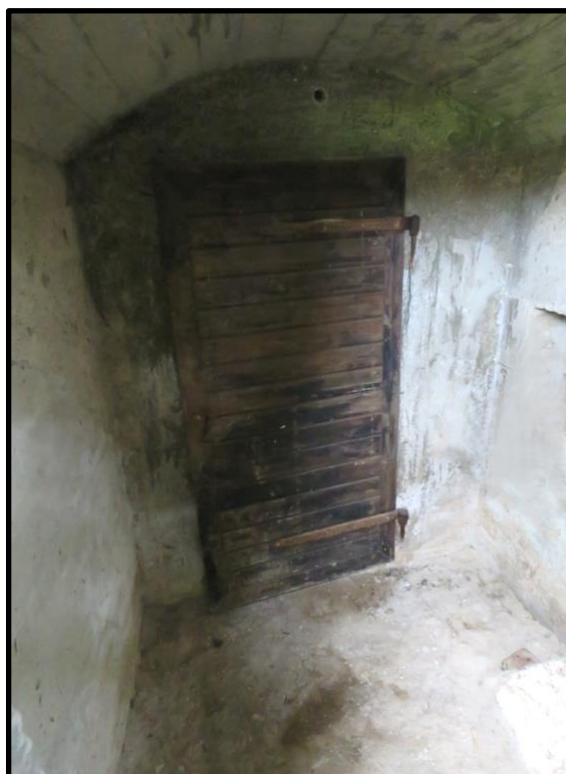
Jordkällaren som renoverades samtidigt som Stora Kopparbergs Bergslag, renoverade skolhuset då skolan hade upphört 1948.
