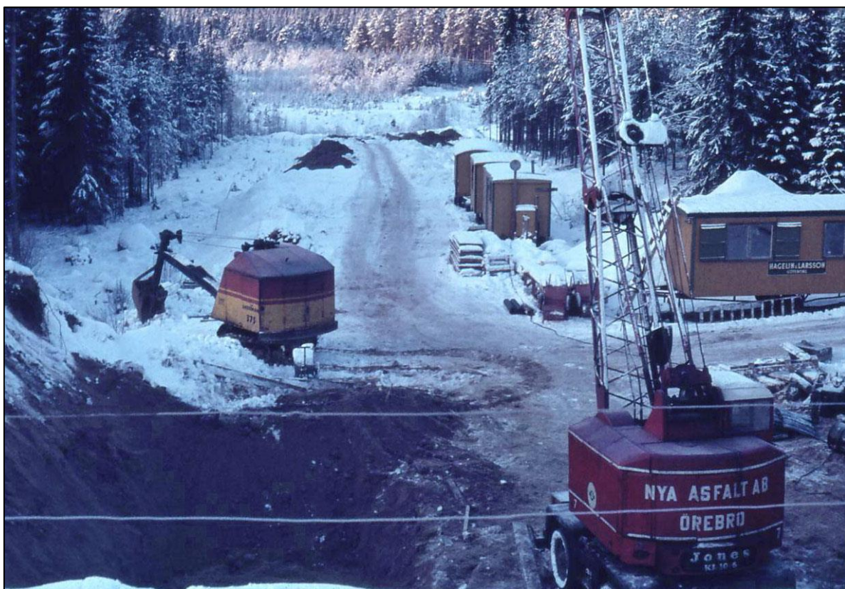
Vägbygget i full gång vintern 1967.
