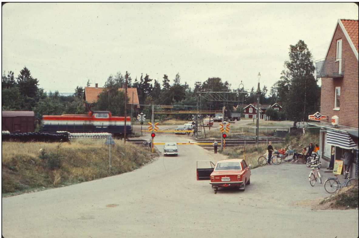
En vecka före högeromläggningen 1967 såg det ut så här vid järnvägs korsningen. Foto Arne Sjöstedt.
