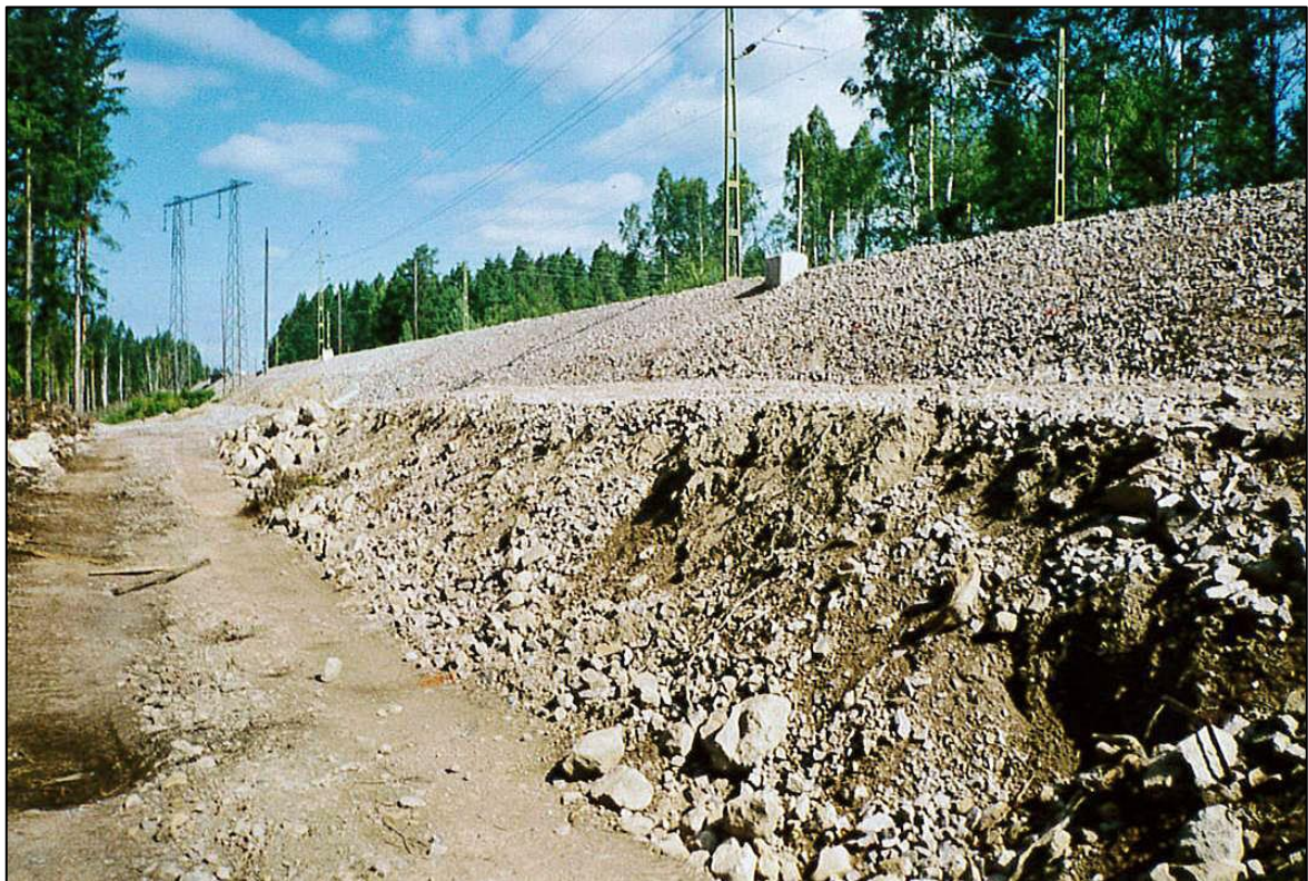
Den nya banvallen har byggts upp. Foto Jesper Carlsson.
