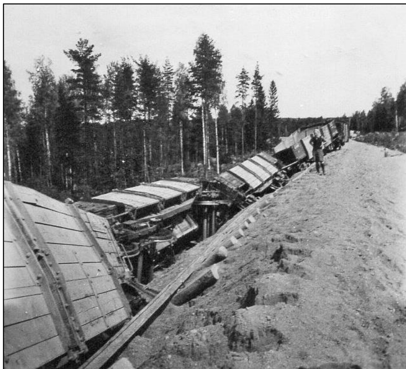
Under arbetet med dubbelspåret 1941 brast banvallen och ett arbetståg la sig på sidan vid Mobäcken. Foto Arvid och Sven Nilsson.
