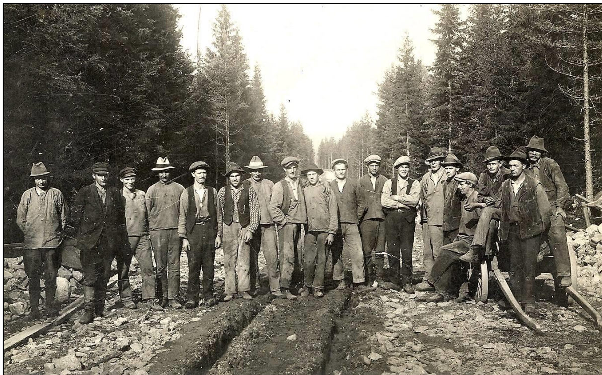
Det här lär vara arbetslaget som byggde stickspåret in till pumphuset. Okänd fotograf.
