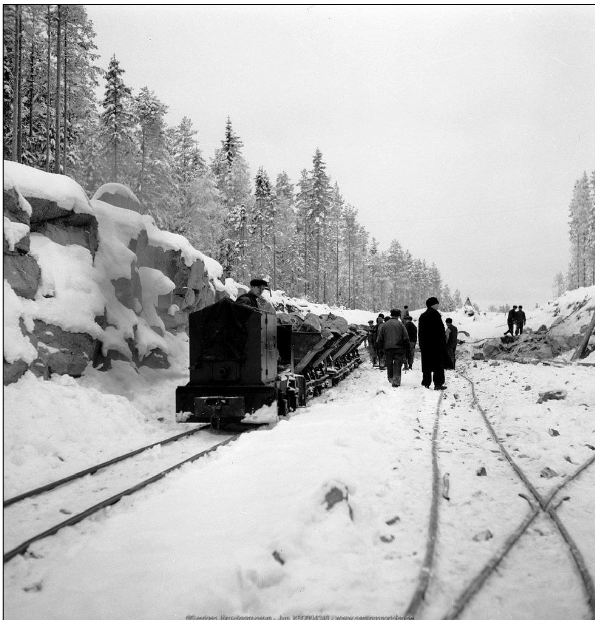
Det nya dubbelspåret fick bitvis en ny sträckning. Här spränger man bort berg för att kunna dra fram de nya spåren. Foto från samlingsportalen.se.
