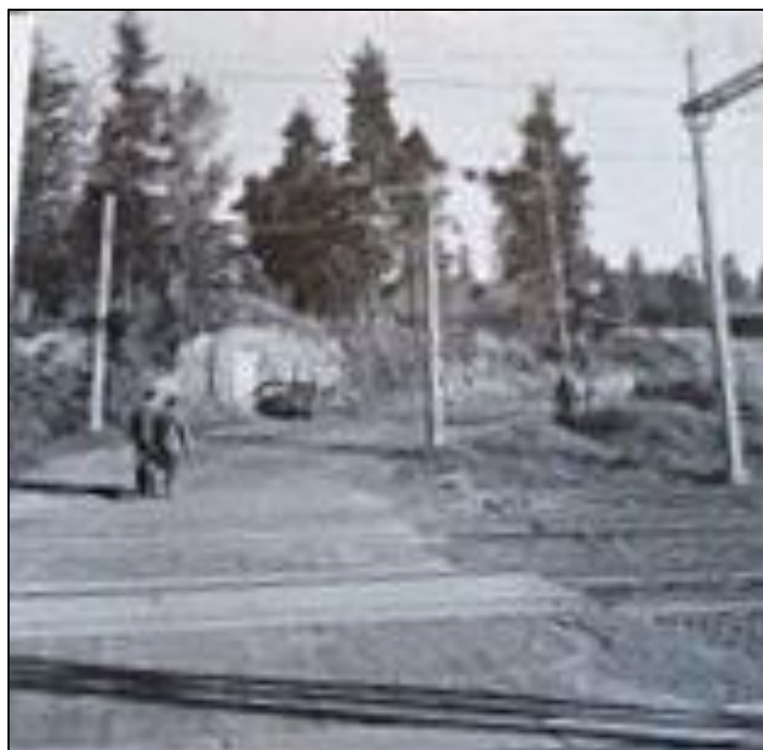
Järnvägs korsningen som den såg ut innan ombyggnaden. Foto Bert Stålhammar.
