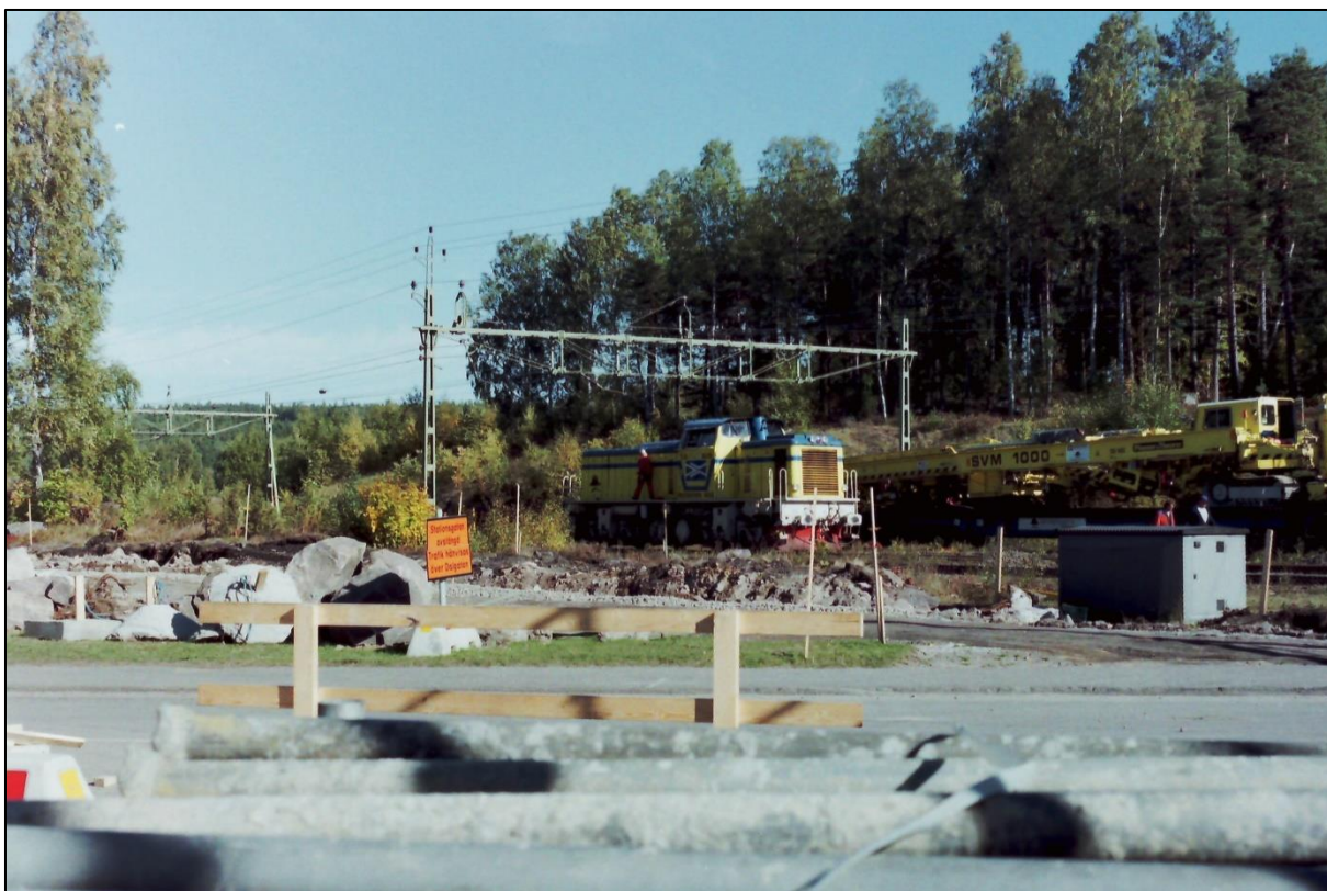
Arbetsfordon vid brobygget. Foto Hilding Karlsson.
