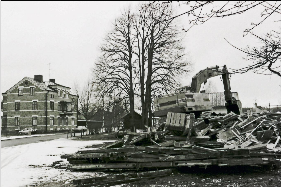
Grävskopan gjorde slut på stationshuset i januari 1991. Okänd fotograf.
