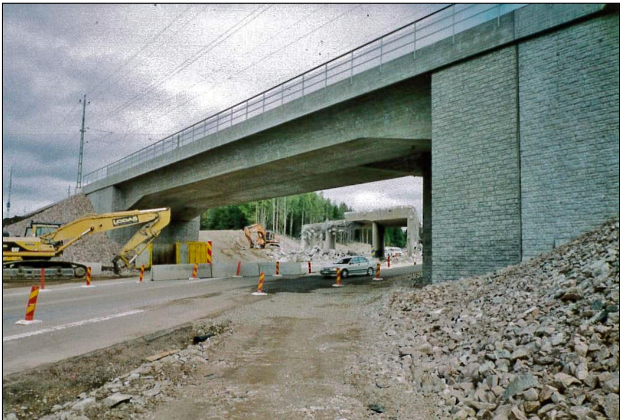
Gamla bron har börjat rivas. Foto Jesper Carlsson.
