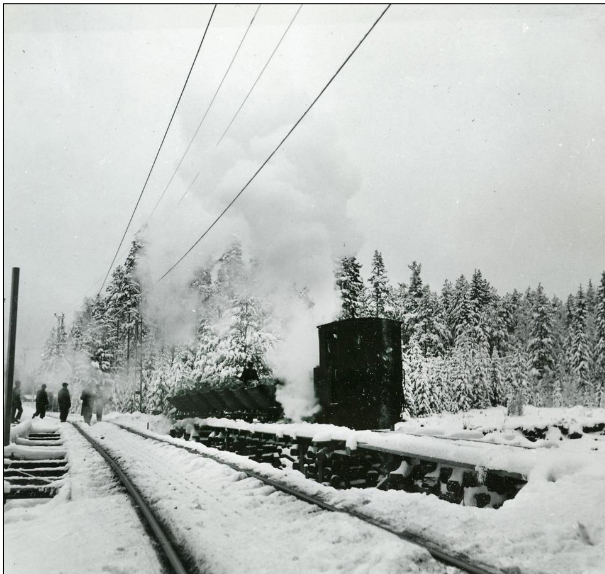
Här läggs det nya spåret bredvid det befintliga. Foto från samlingsportalen.se.
