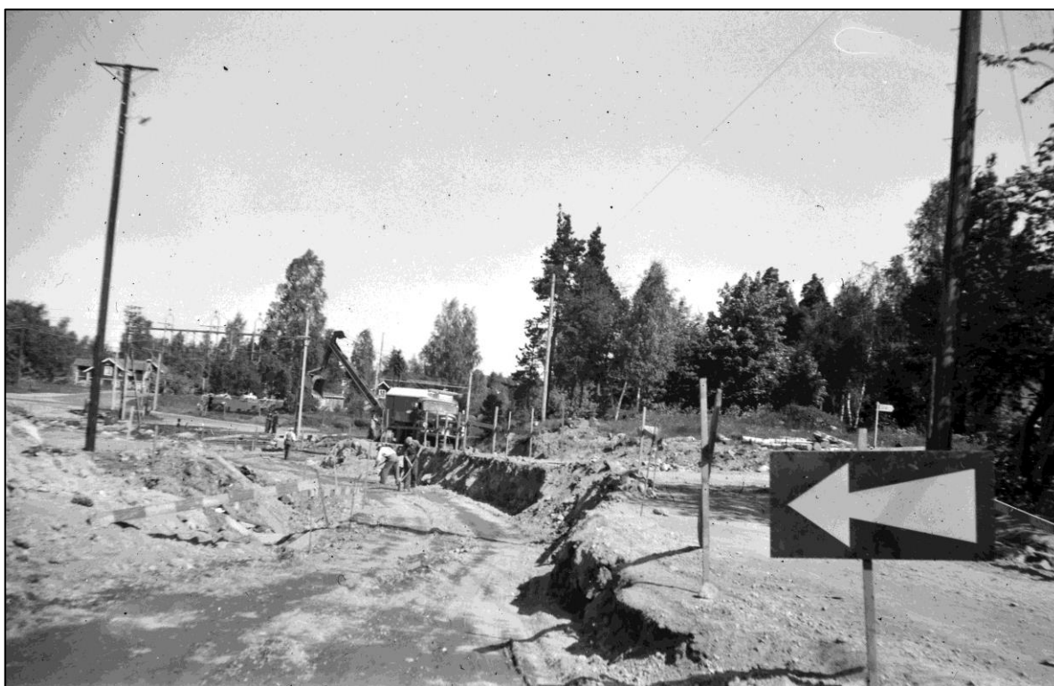
Arbetet med att flytta plankorsningen några meter påbörjades 1953. Foto Arne Sjöstedt.
