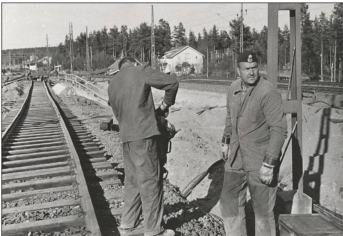
Harry Spann arbetar med spårömläggning i april 1967 i samband med att bron över den nya landsvägen mellan Paradistorg och Tived byggs. Okänd fotograf.
