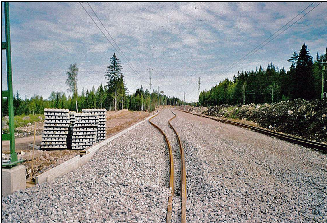
Rälsen har börjat läggas ut. Foto Jesper Carlsson.
