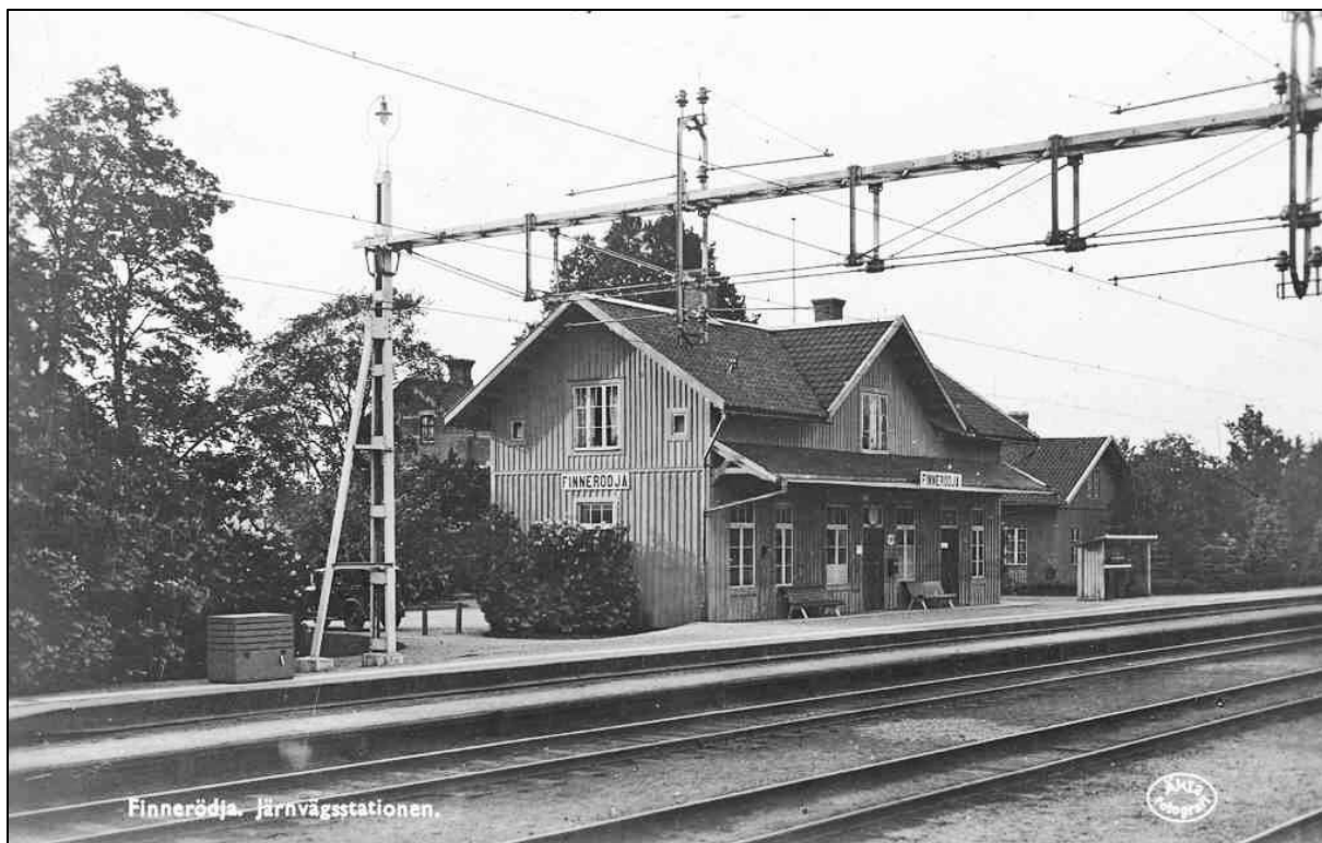
Stationshuset som det ser ut efter takhöjningen. Fönstren på övervåningen har blivit större och taket ser annorlunda ut. Fotot taget omkring 1930. Okänd fotograf.
