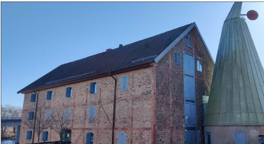
Stadens torkria byggdes om till museum och är idag hela Hallands museum för design-, konst- och kulturhistoria samt förstås – fika! Bild: Rian.
